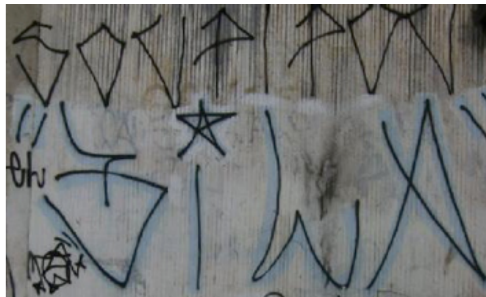
Figura 16: Muro com pixação sou pipou , que se encontra acima de outras inscrições.
