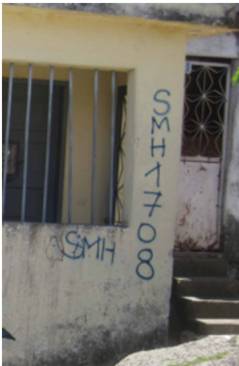
Figura 15: Pichações do governo demarcando demolições pretendidas.
