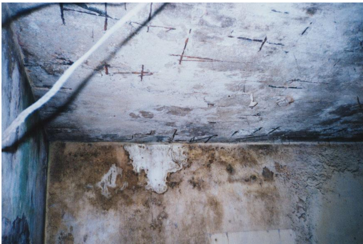
Figura 4: Foto de um dos cômodos da casa nº 387 da Rua Professor Plínio Olinto, Vila São Bento, Bangu, RJ – Residência da Sra. A. Fonte: Arquivo Pessoal.
