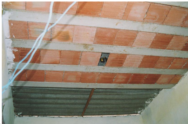
Figura 11: Foto da laje com vão para escada de acesso ao pavimento superior da casa Nº 16 da Travessa Saturno, Vila São União da Paz, Bangu, RJ – Residência da Sra. E. Fonte: Arquivo Pessoal.
