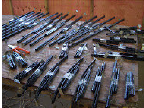
Figura 13: Oficina de trabalho em canteiro de obras. Ferragens Etiquetadas. Fiocruz, 201?
