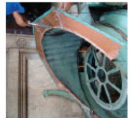
Execução de selada
