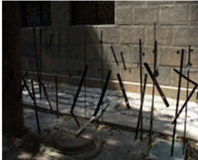
Figura 8: Oficina de trabalho em canteiro de obras. Recuperação de ferragens. Fiocruz, 2011?
