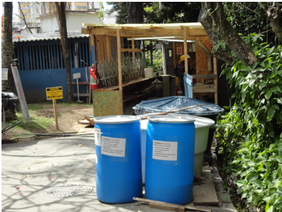
Figura 9: Oficinas de trabalho em canteiro de obras. Hidratação da cal e Serralheria. Palácio Laranjeiras. 2014.
