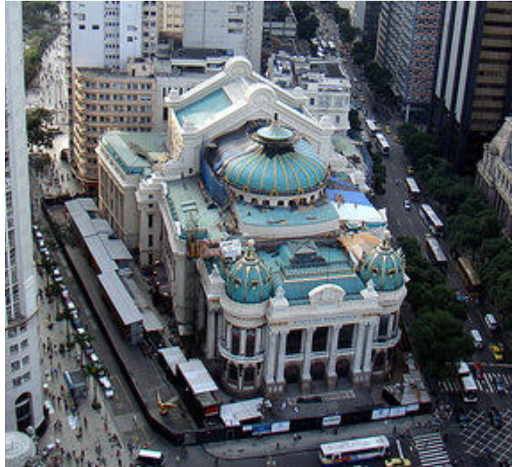
Figura 10: Canteiro da obra de Restauração do Teatro Municipal do Rio de Janeiro.
