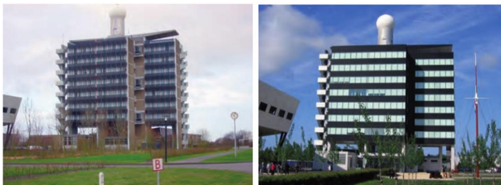
Figura 11 – Reabilitação do edifício Albatros, na Holanda, antes e após reabilitação. Fonte: Baker (2009).
