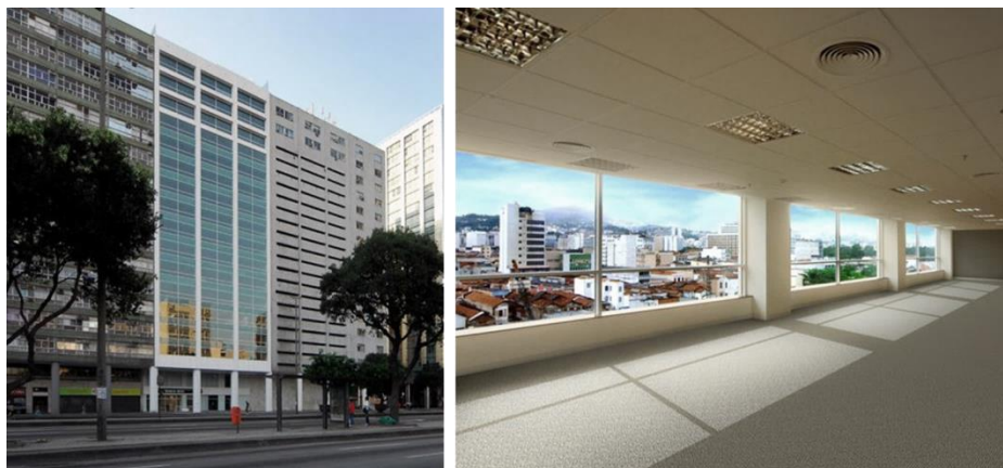
Figura 22 – Torre Vargas, após reabilitação. Fonte: Latour (2014).
