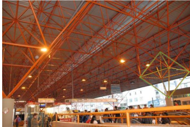
Figura 57. Trelças Espaciais aplicadas em cobertura
