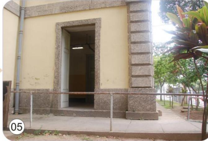
A esquerda da foto, junto ao prédio principal, passeio em lajes de pedra, e do lado direito da foto, semi enterrada, cobertura em concreto armado da casa de bombas utilizada para captar água da cisterna.
