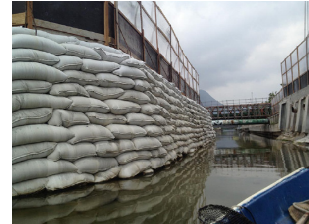
Fig. 2. 18 Barragem construída dentro do Canal pela Obra da Linha 4 do Metrô, reduzindo a menos da metade a largura de um trecho do Canal. Novembro 2014. Foto da autora. Apoio: Alexander pescador.
