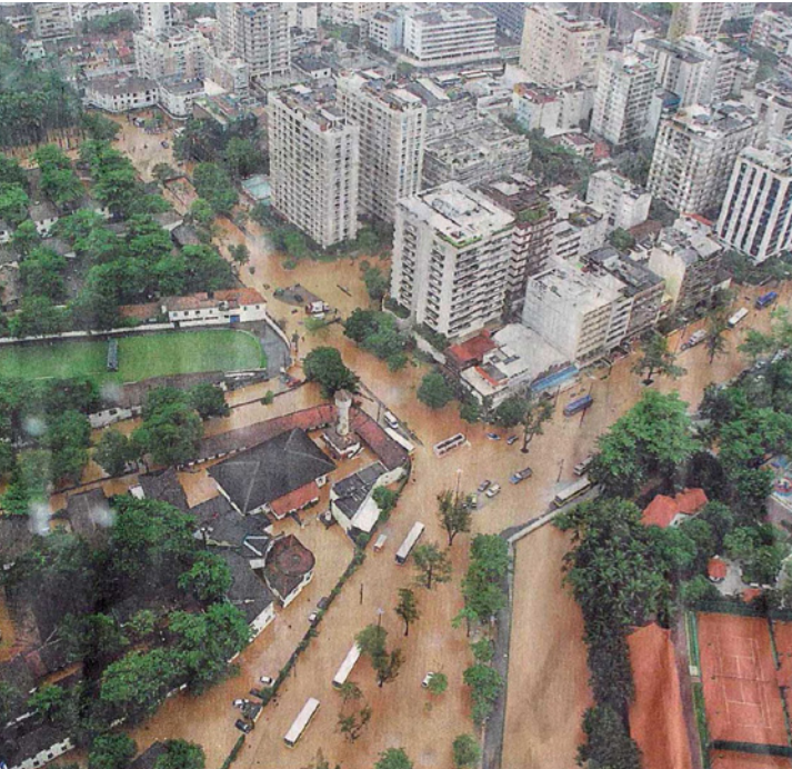
Fig. 2.12 Foto aérea da área do Piraquê durante a enchente de 2010. Foto de jornal cedida por Flávio Coutinho. Segundo o engenheiro, não só a Lagoa transbordou, como também os canais.
