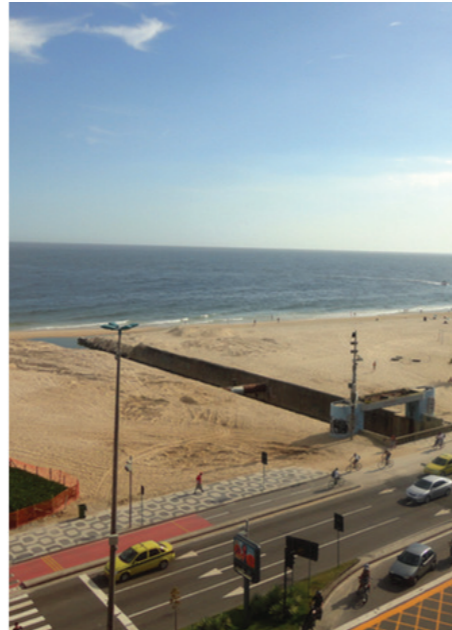
Fig. 2. 6 Trecho conhecido como embocadura do Canal. Foto: Techno Bio.
