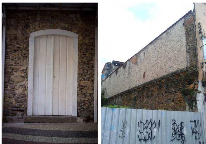
**Figura 34 - Sistema construtivo em pedra argamassada nas fachadas de edificações da Rua do Comércio. Fonte: Arquivo do autor, 2015.**
