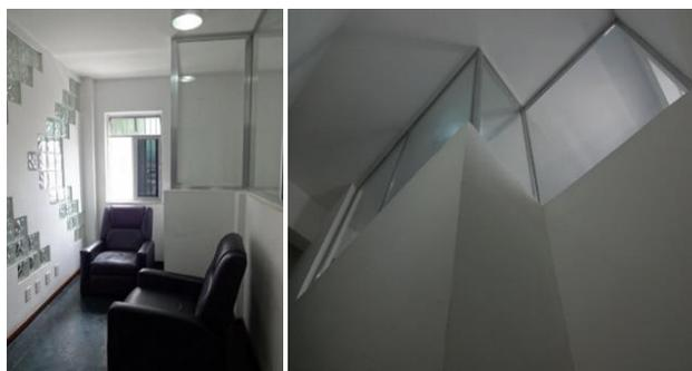
**Figura 91.** Painéis de vidro no vão do terceiro pavimento.
