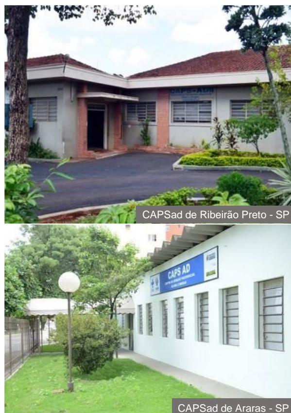
**Figura 33.** Uso de janelas basculantes em CAPSAD.
