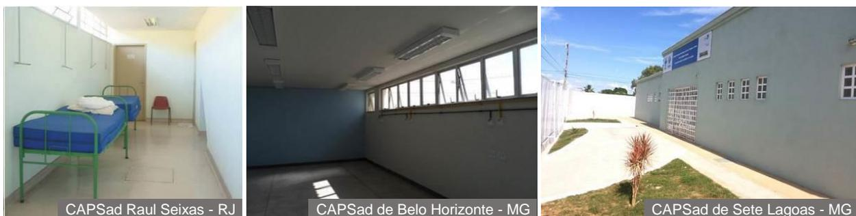
**Figura 34.** Salas de repouso e fachada de CAPSAd com esquadrias instaladas em altura inadequada.
