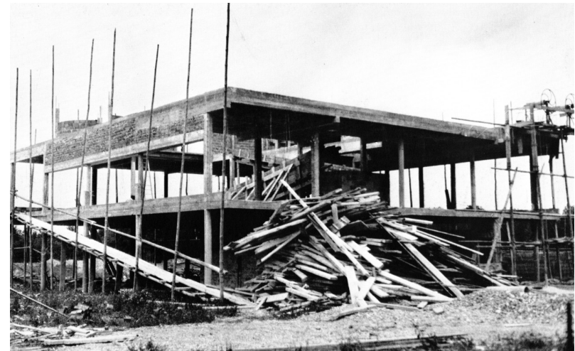
Fig. 2 A construção da Villa Savoye, 1928. Fonte: http://asqimo.tumblr.com/
