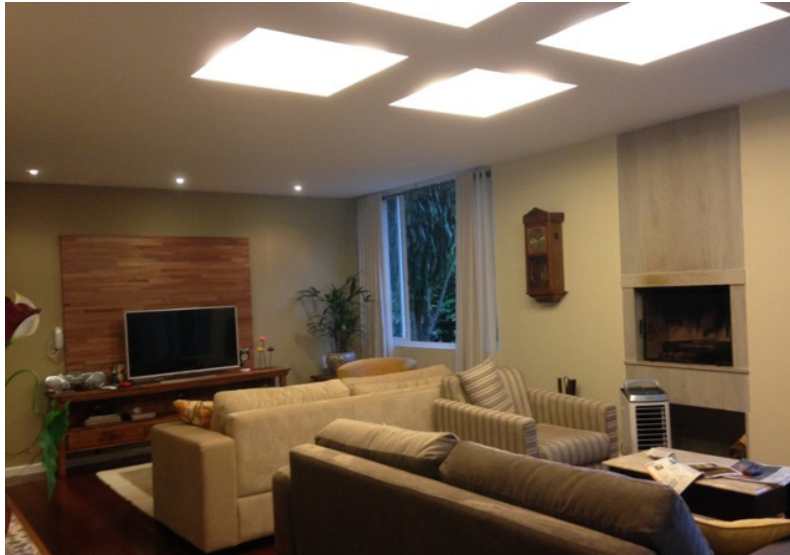
Fig. 123 Sala de estar construída nos pilotis, com forro rebaixado em gesso encobrindo a laje nervurada. Observa-se também a nova lareira. Fonte: Da autora, 2015.
