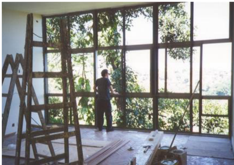
Fig. 69 Esquadrias da fachada Sudoeste durante as obras em 2001. Fonte: Arquivo pessoal George Kornis.
