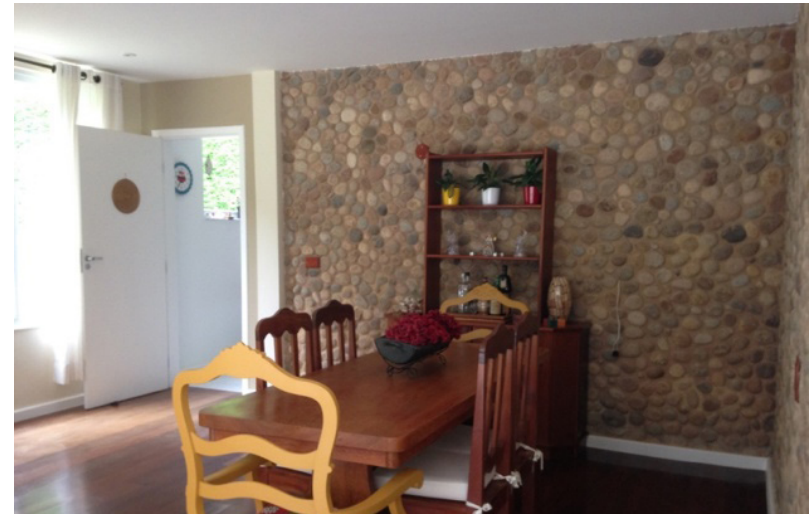
Fig. 119 Parte da alvenaria de pedra rolada remanescente Fonte: Da autora, 2015.
