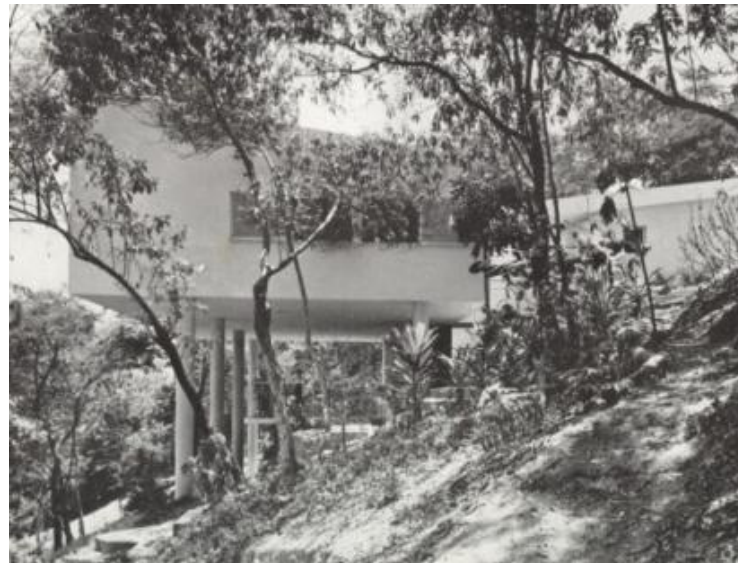
Fig. 64 Fachada noroeste, 1952. Fonte: Arquivo pessoal Geoge Kornis
