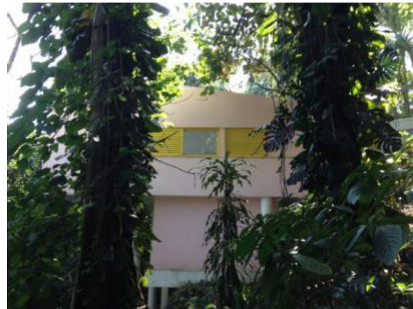
Fig. 57 Estado de conservação em 2012. Fonte: Da autora.
