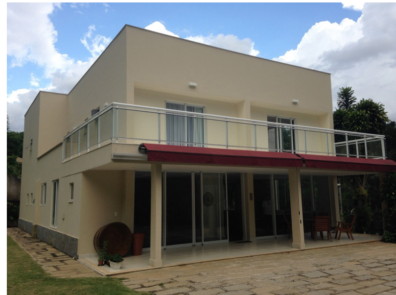
Fig. 100 A Residência de Fim de Semana atualmente. Fonte: Da autora, 2015.
