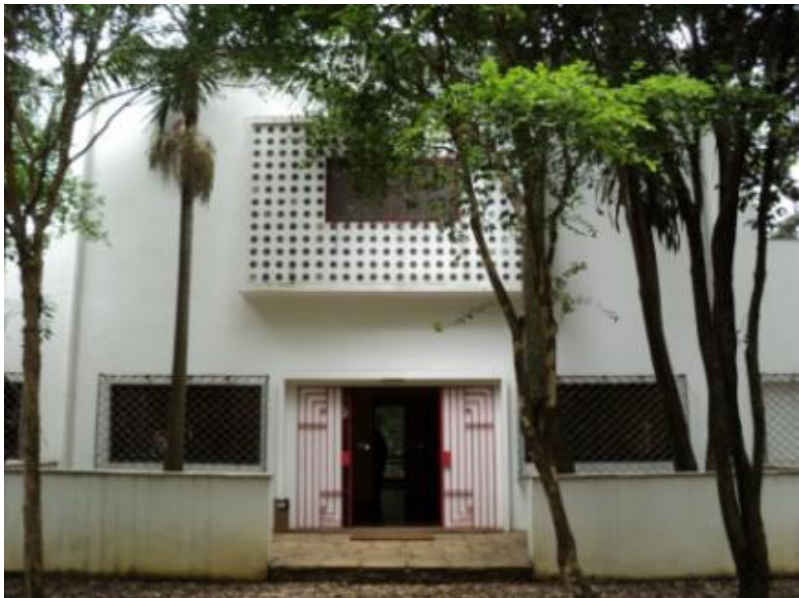
Fig. 8 A residência em 2011. Fonte: Da autora.
