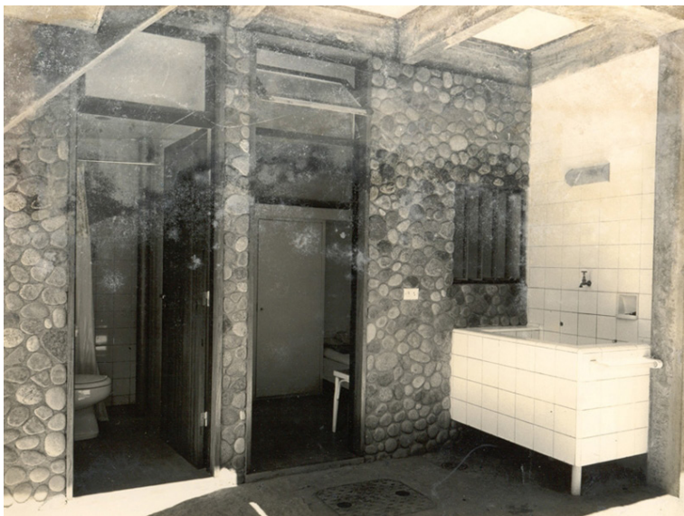
Fig. 92 Área de serviço e entrada do banheiro e quarto do caseiro, década de 1960. Fonte: Acervo NPD - FAU - UFRJ.
