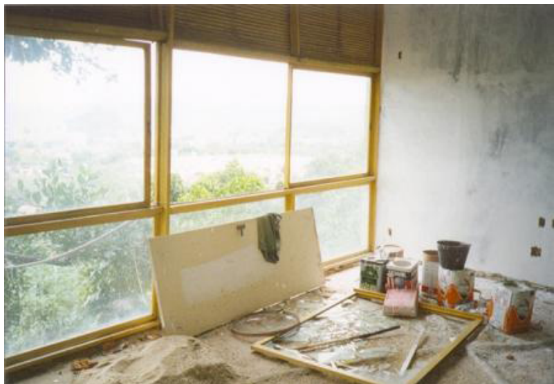
Fig. 68 Esquadrias da fachada Sudoeste antes de sua remoção. Fonte: Arquivo pessoal George Kornis, 2001.
