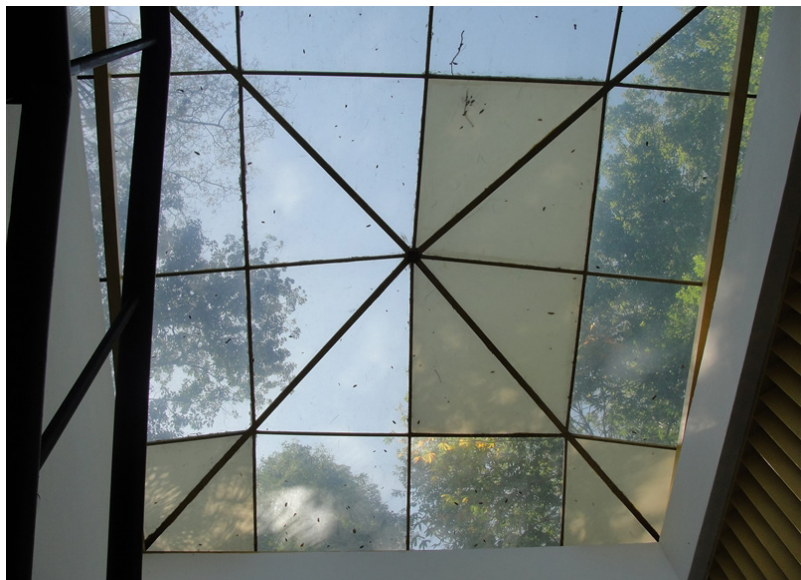
Fig. 75 Claraboia piramidal com vidros de tonalidades diferentes. Fonte: Da autora, 2012.
