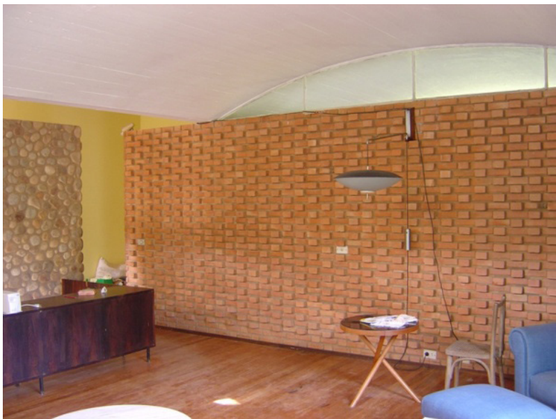
Fig. 121 Vista parcial da sala de estar em 2006 com seus revestimentos originais. Destaca-se a alvenaria com tijolos intercalados. Fonte: Acervo Pesquisa Casas Brasileiras do Séc XX.
