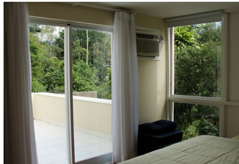
Fig. 126 Dormitório original, com nova porta de correr em alumínio e vidro à esquerda e esquadria remanescente em madeira. Fonte: Da autora, 2015.
