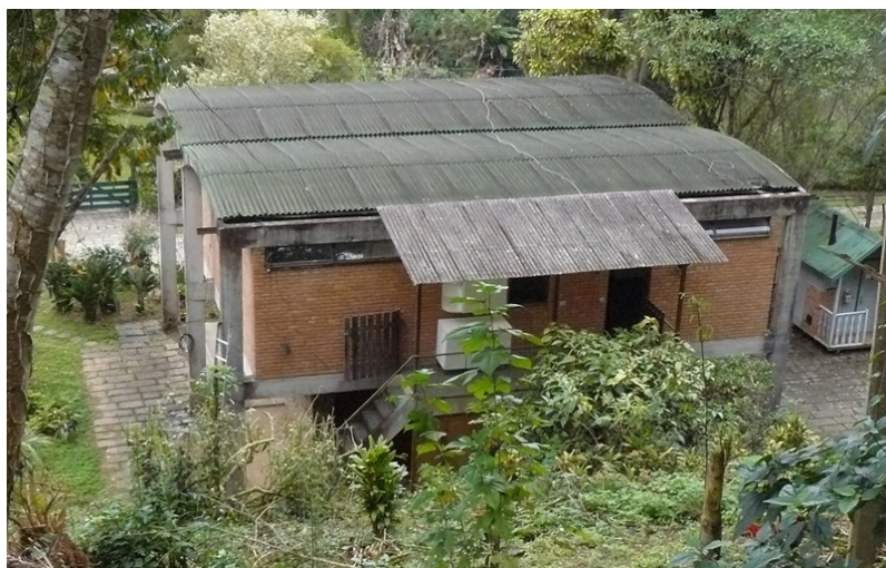
Fig. 114 Vista parcial da residência em 2008, já com telhas de fibrocimento fixadas sobre as abóbadas de concreto e telhado sobre varanda de serviço. Fonte: Acervo Pesquisa Casas Brasileiras do Séc XX.
