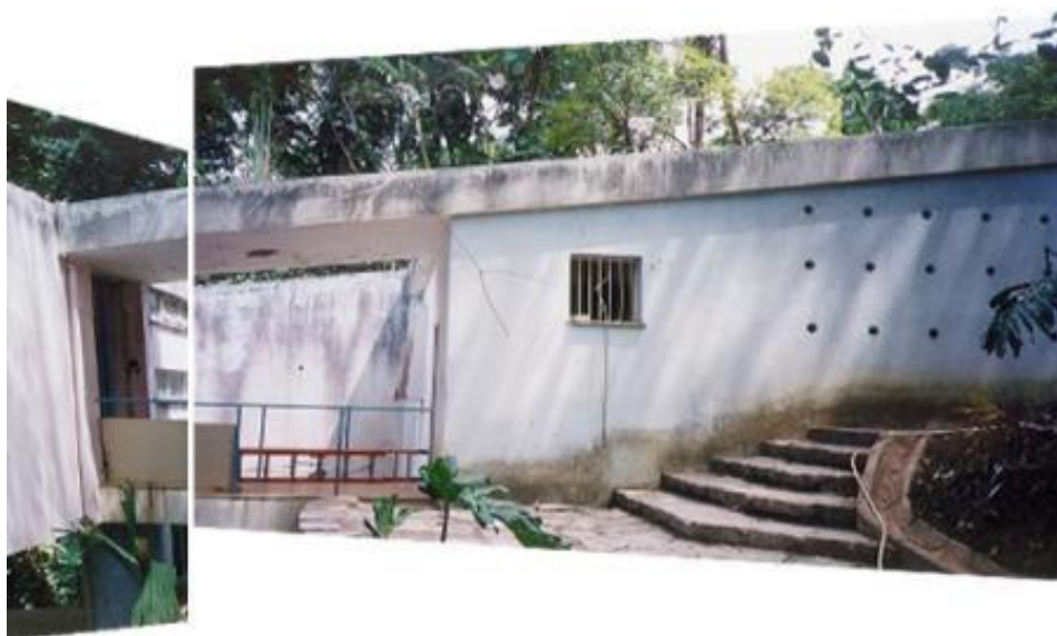
Fig. 74 Fotomontagem parcial da Fachada Sudeste com a passarela antes das obras, em 2001. Fonte: Arquivo pessoal George Kornis.
