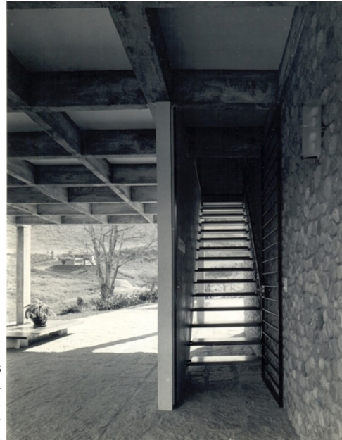
Fig. 95 Vista parcial dos pilotis e escada social, década de 1960. Fonte: Acervo NPD - FAU - UFRJ.
