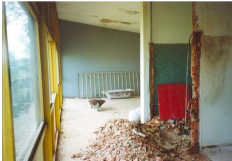
Fig. 83 - Demolição da parede da varanda, que limitava o banheiro e o quarto. Ao fundo vê-se a esquadria em bscula vertical removida. Fonte: Arquivo pessoal George Kornis, 2001.
