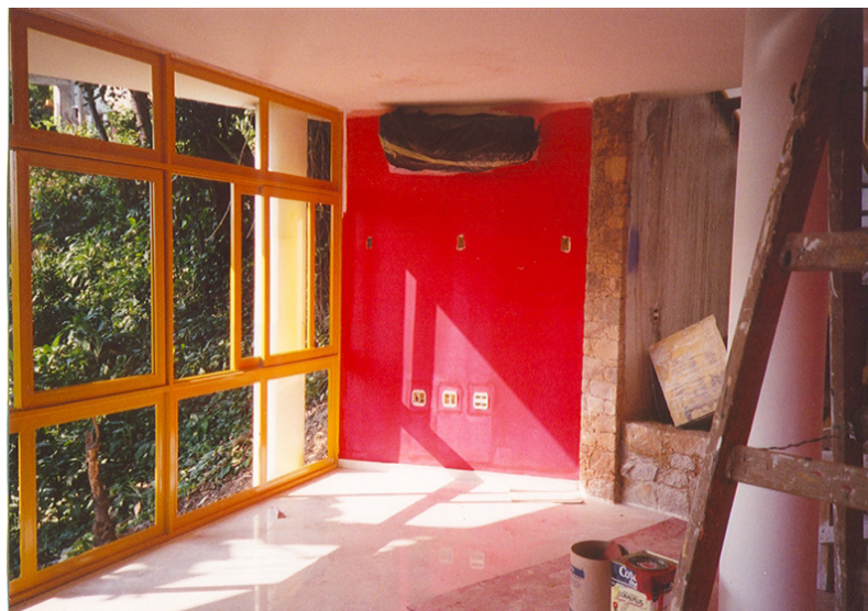
Fig. 71 Instalação das esquadrias no pavimento inferior. Fonte: Arquivo pessoal George Kornis, 2001.
