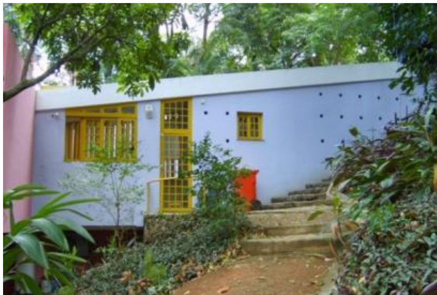
Fig. 76 Vista da atual da Fachada Sudeste com o fechamento da área de serviço. Fonte: Da autora, 2012.
