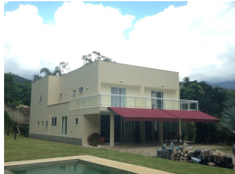
Fig. 106 A residência em 2015. Fonte: Da autora.
