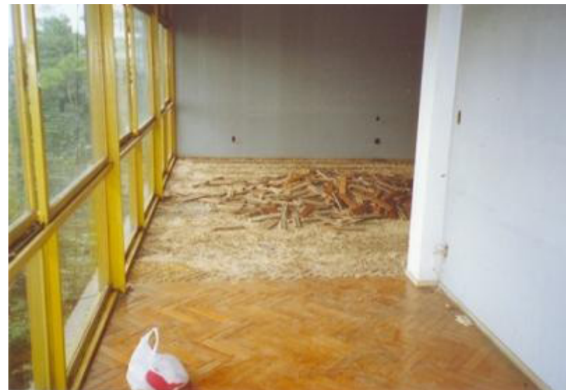
Fig. 80 Remoção do piso em taco de madeira. Fonte: Arquivo pessoal George Kornis, 2001.
