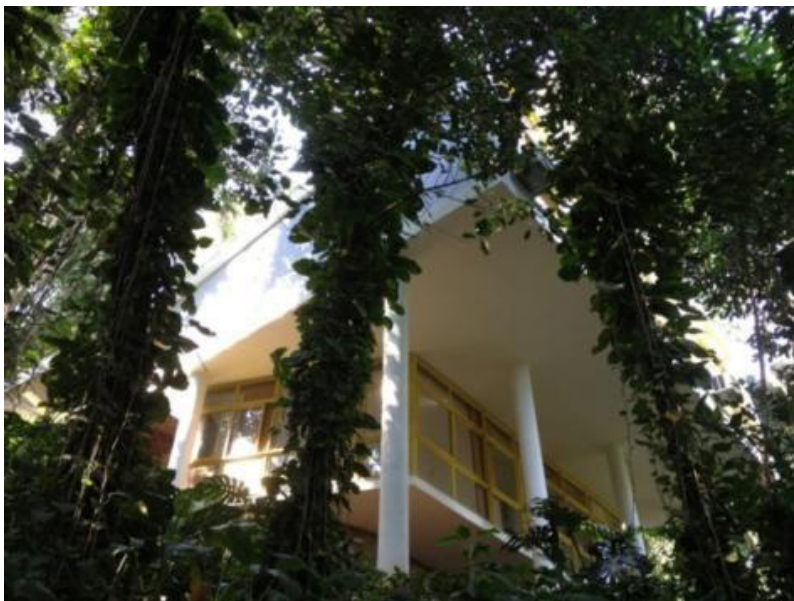
Fig. 63 - A residência em 2012. Fonte: Da autora.
