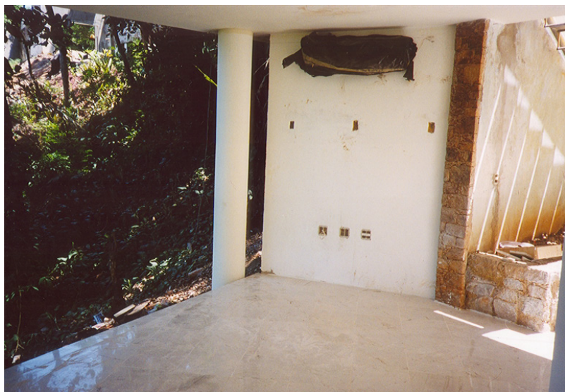
Fig. 70 Obras de ocupação da laje do pavimento inferior. Fonte: Arquivo pessoal George Kornis, 2001.
