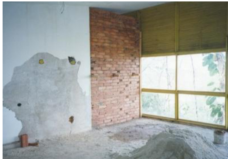
Fig. 84 Prolongamento da alvenaria at a esquadria da fachada Sudoeste. Fonte: Arquivo pessoal George Kornis, 2001.
