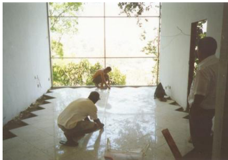
Fig. 82 Instalação do piso cerâmico na suíte. Fonte: Arquivo pessoal George Kornis, 2001.
