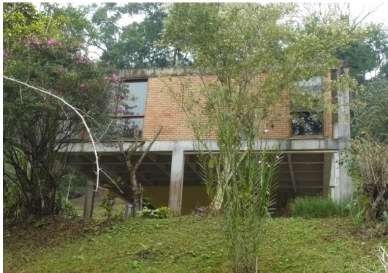
Fig. 110 Fachada Sudoeste com vista parcial da laje nervurada. Fonte: Acervo Pesquisa Casas Brasileiras do Séc XX, 2008.
