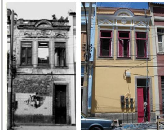
Figura 24: Estado do imóvel na Rua do Livramento 147 antes da obra e fachada reformada. Fonte: [http://www.moradiacentral.org.br/pdf/apr\\_sp\\_Rio\\_NovasAlternativas\\_Nazih.pdf](http://www.moradiacentral.org.br/pdf/apr_sp_Rio_NovasAlternativas_Nazih.pdf)
