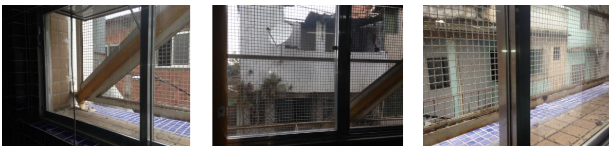
Figura 133: Vistas das salas de aula Fonte: a autora
