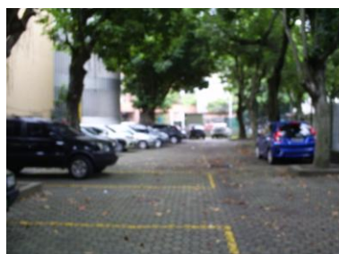
Figura 96: Estacionamento - Piso em blocos intertravados Fonte: a autora
