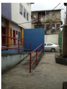
Figura 138: Acesso de serviço e estacionamento Fonte: a autora
