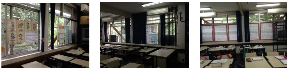
Figura 108: Salas de aula Fonte: a autora
