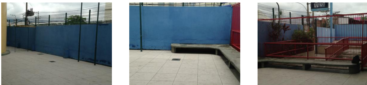
Figura 143: Pátio descoberto 2 Fonte: a autora
