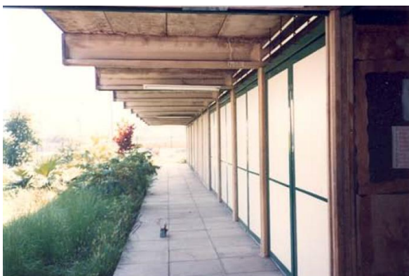
Figura 21: E.M. Tia Clata - edificação original (1989) Av. Presidente Vargas s/nº, Centro Fonte: Azevedo (1995)
