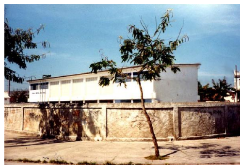
Figura 16: E.M. Pintor Lazar Segal (1963) Praça Estado de Israel, s/nº - Realengo Tipo Econômico 2P/5S/63 - Fonte: Ehrlich (2002)
