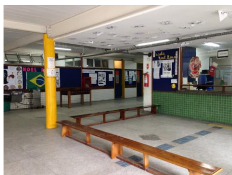
Figura 118: Pátio Coberto Fonte: a autora
