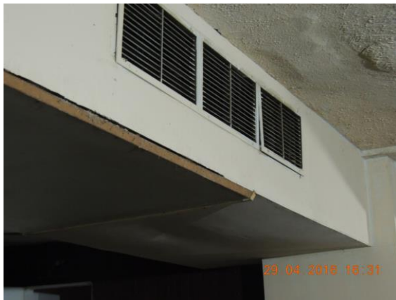
Figura 2.32: Sistema de refrigeração e patologia no teto. Fonte: arquivo pessoal.
