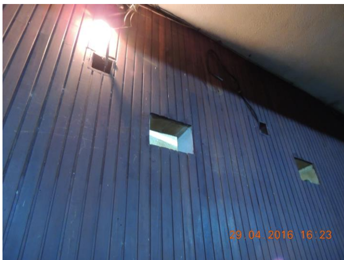
Figura 2.28: Abertura dos projetores. Fonte: arquivo pessoal.
