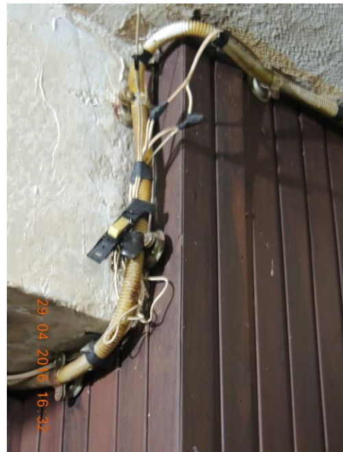
Figura 2.31: Instalação elétrica existente. Fonte: arquivo pessoal.
