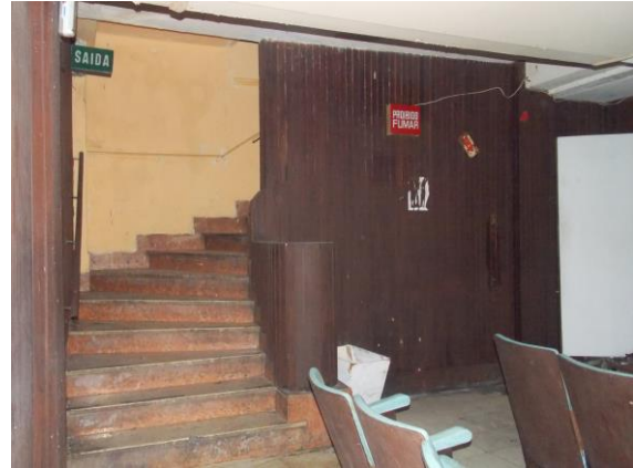
Figura 2.21: Escada de emergência em direção a galeria do Edifício Teatro Regina. Fonte: arquivo pessoal.
