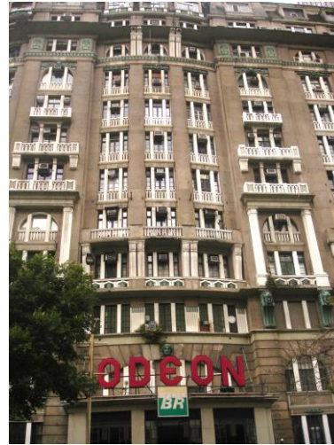
Figura 2.07: Edifício do Cine Odeon – Salas comerciais nos andares superiores. Fonte: http://www.conexaojornalismo.com.br/ . Acesso em: abril de 2016.
