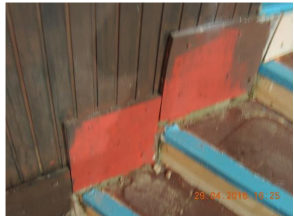
Figura 2.33: Rodapés e detalhe construtivo da escada interna. Fonte: arquivo pessoal.
