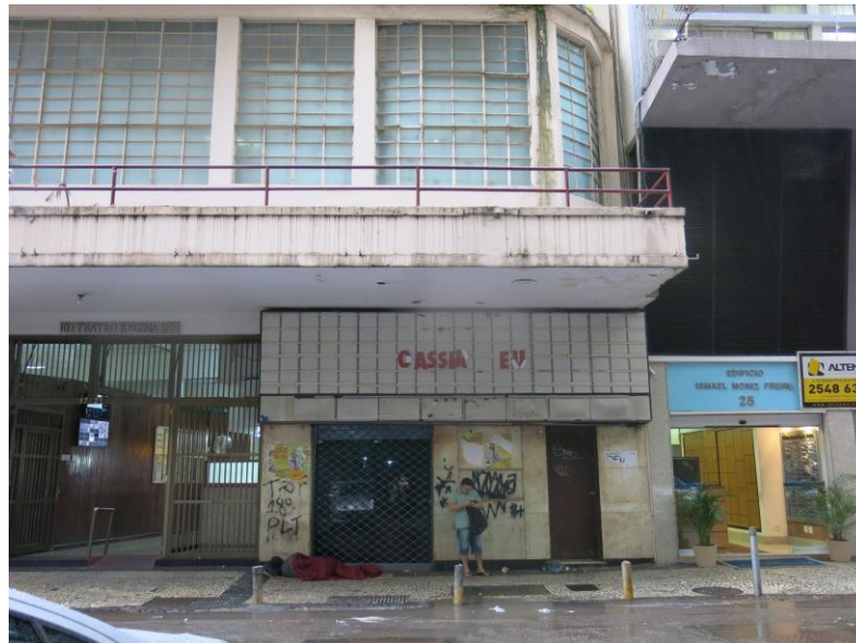
Figura 2.16: Fachada do Cine Orly. Fonte: arquivo pessoal.
