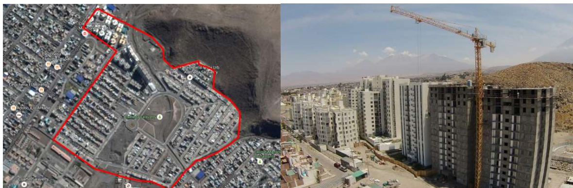
Figura 17: conjunto habitacional “El mirador de la Alameda”. Fonte: google earth
