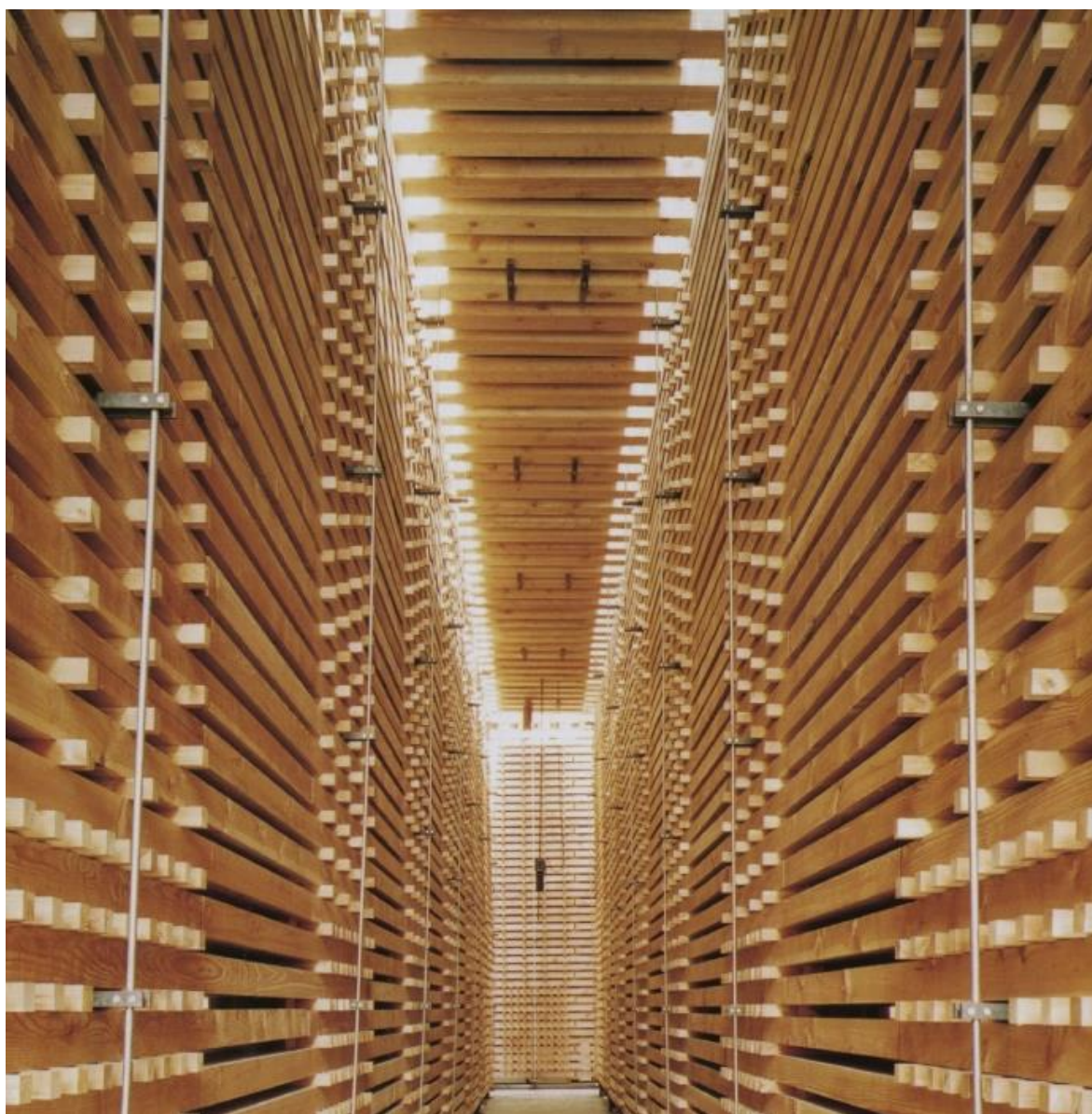
Fig. 4 – Sound Box , Pavilhão da Suíça na Expo 2000 em Hanover. (ZUMTHOR, 2006 p.34)
