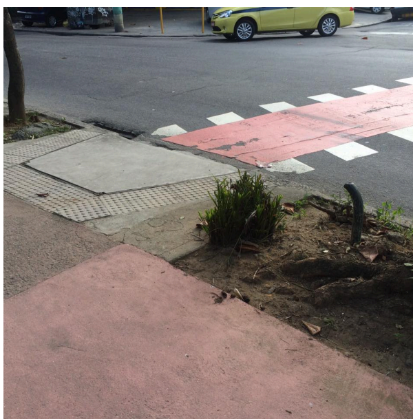
Figura 41 -Rampa para “acessibilidade”
