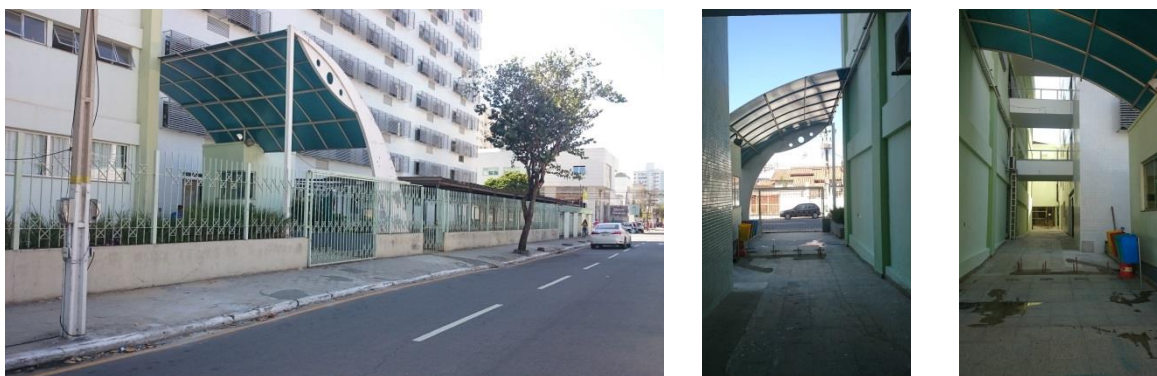
Figura 29 Acesso aos Estudantes em obra. Fonte: Própria, 2016
