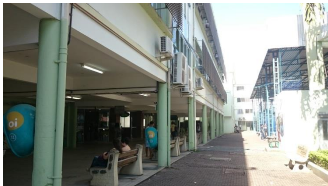
Figura 49 Área adjacente ao Pátio Coberto
