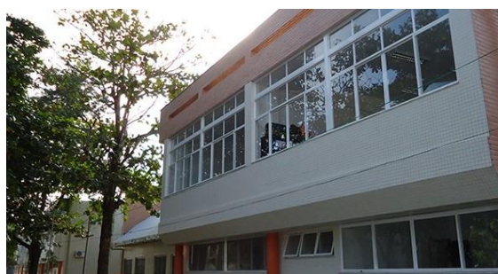
(b) Novo edifício da EM Joaquim Macedo
