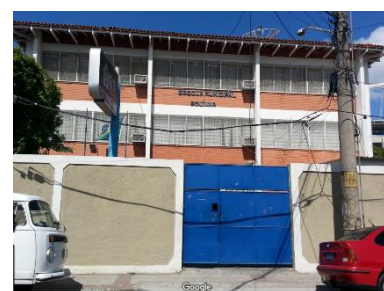
(c) Muro Frontal GEC Bolívar, Engenho de Dentro Fonte: GoogleMaps, 2016.
