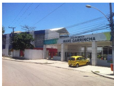
(a) Cobertura no acesso, GEO Felix, Caju.
