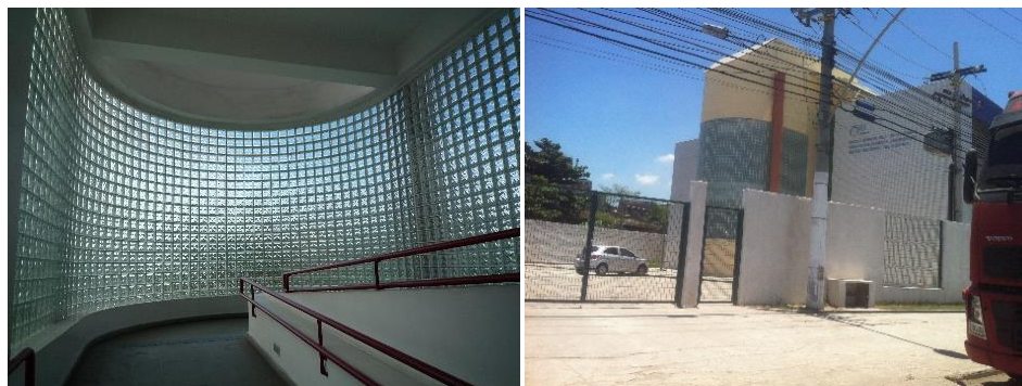
(a) Rampa de acesso aos pavimentos, GEO Felix, Caju.
