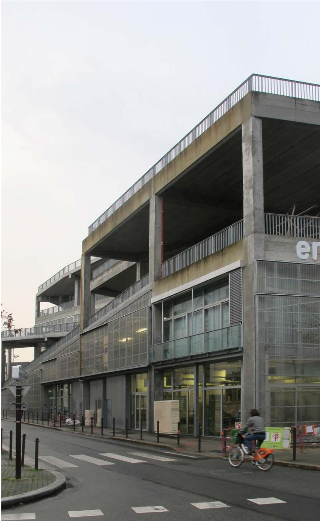
**Figura 3.15:** Fachada Sul-Oeste da Escola de Nantes, 2015. Materiais de fechamento e estrutura em elementos pré-fabricados. Fotografia: Pedro Varela.
