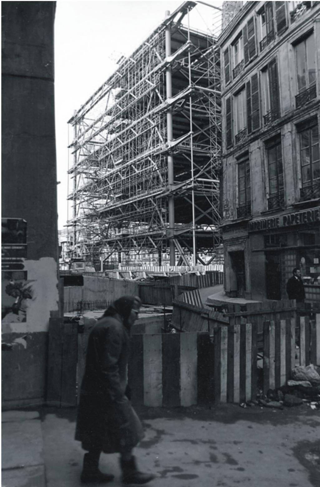
**Figura 1.29:** Fotografia da construção do Centro Pompidou. A imagem mostra a sobreposição de lajes livres no interior do edifício, possibilitadas pelo complexo sistema de pórticos estruturais do tipo gerberetti, projetados pelo engenheiro Peter Rice. Richard Rogers e Renzo Piano, 1969 Fonte: Fundação Renzo Piano.
