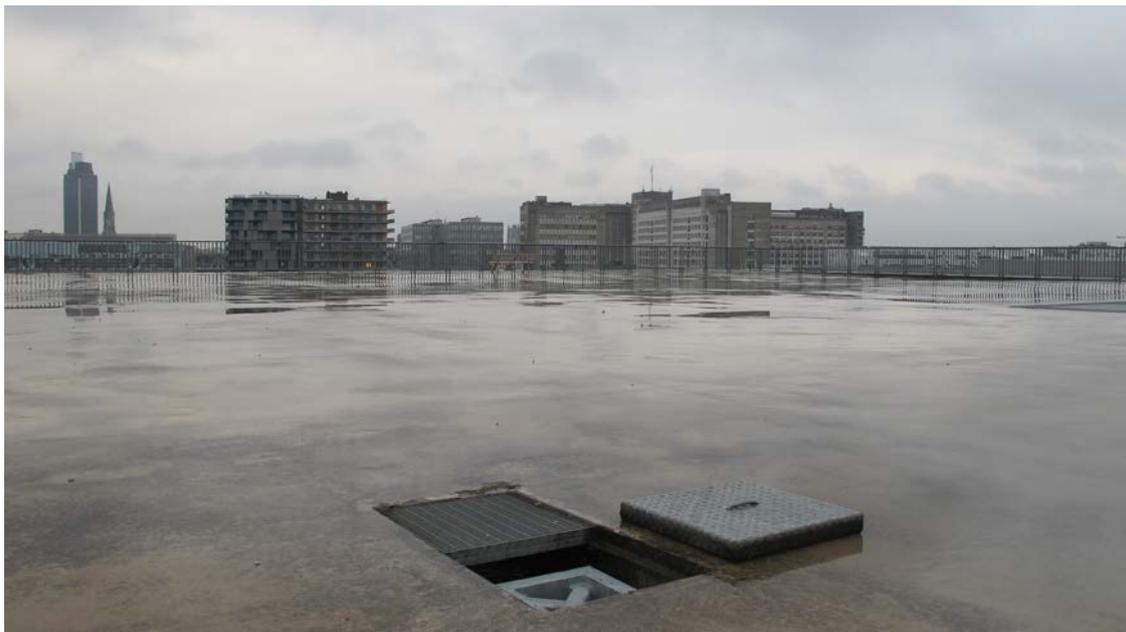
**Figura 4.6:** Imagem do terraço. Espera metálica construída para permitir montagem de tendas efêmeras.
