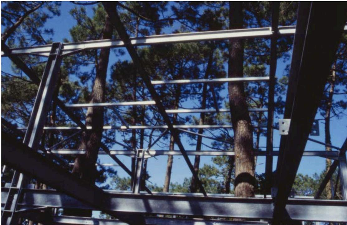
**Figura 2.12:** Construção da estrutura metálica da casa de Cap Ferret. Lacaton e Vassal, 1996-1998. Fonte: Revista El Croquis 177/178.
