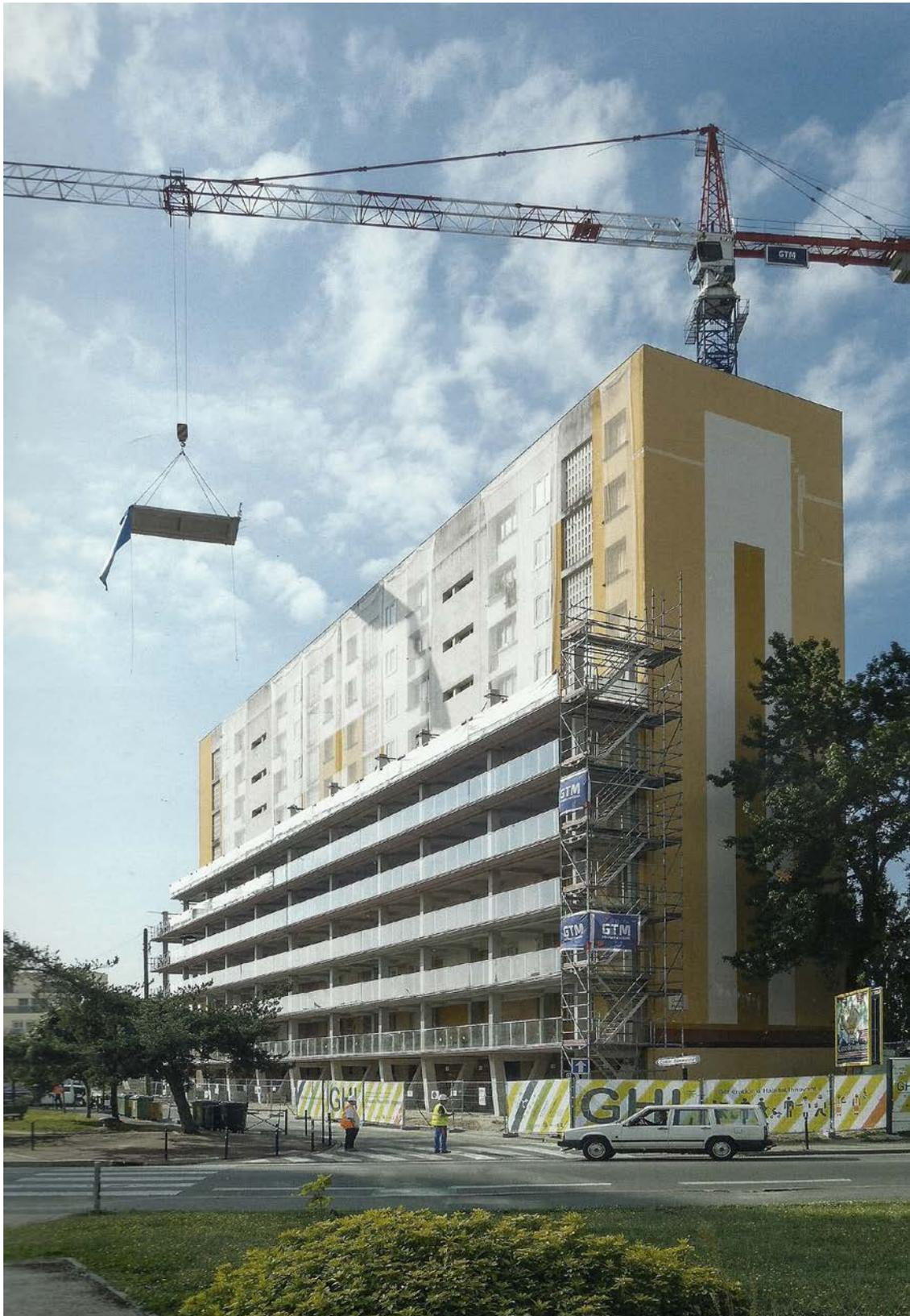
**Figura 2.4:** Edifício de Habitação em Bordeaux. 2011-(2016). Construção do acréscimo na estrutura existente. Fonte: Lacaton e Vassal.
