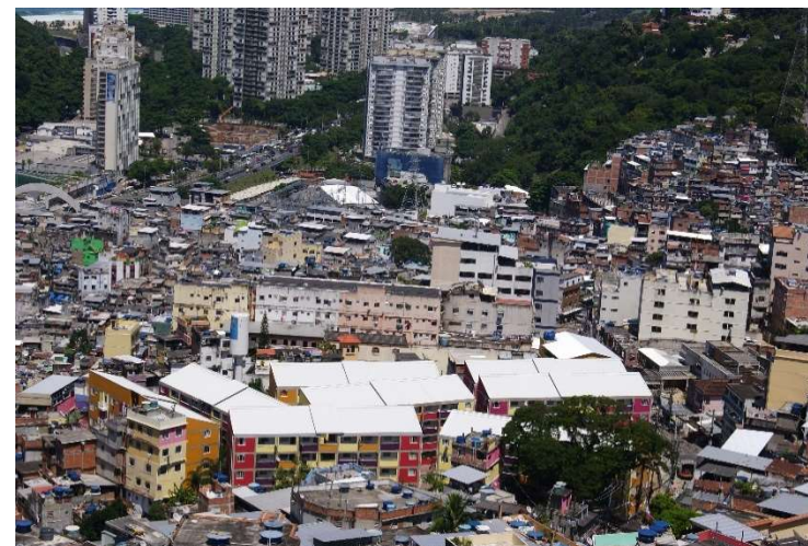
Figura 38: edifícios coloridos executados para realocação de população relocada em razão do alargamento da Rua Quatro. março/2013. foto da autora.
