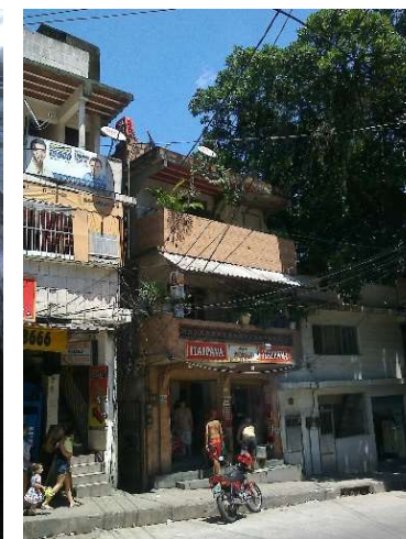
Figura 46: Estrada da Gávea, na lateral da casa ao centro é o acesso a um beco. março/2013. foto da autora.
