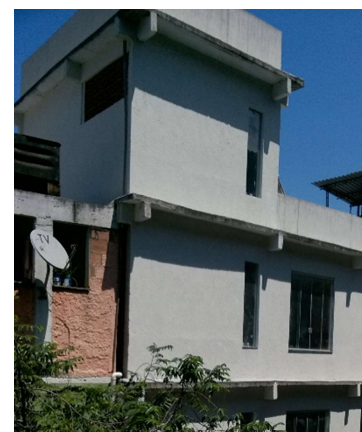
Figura 79: fachada. Out/2016. Foto da autora.
