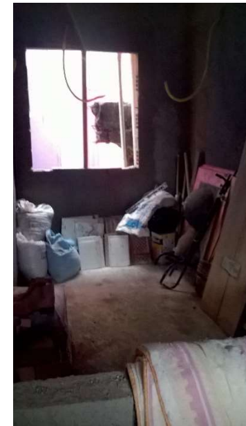
Figura 75: quarto pavimento ainda em obras. set/2016. foto de Raizza Talon.
