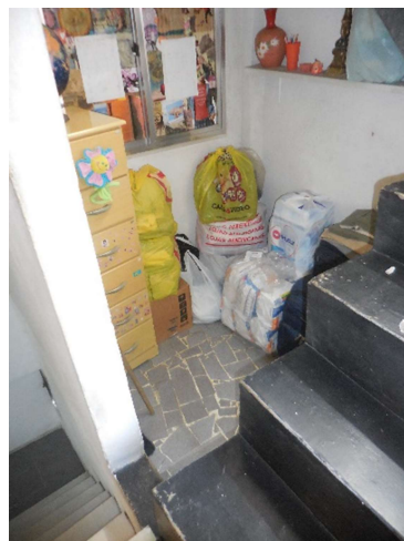
Figura 64: visão do quarto. Janela ao fundo dá para vão de menos de 25cm entre esta casa e a vizinha.
