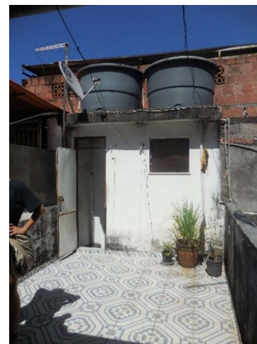
Figura 65: vista do acesso à laje e as caixas d'água da residência. jul/2016. foto da autora.
