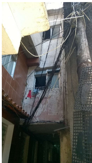
Figura 62: casa d. Dina ao centro. Andares superiores se sobrepõem sobre a rua. out/2016. foto da autora.
