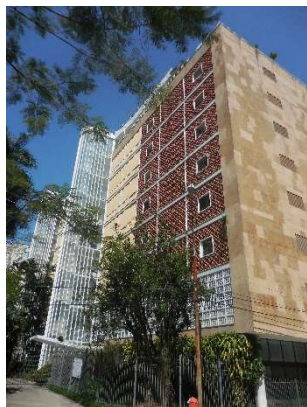
Imagem 59: fachada ed. Nova Cintra. nov/2014. foto da autora.
