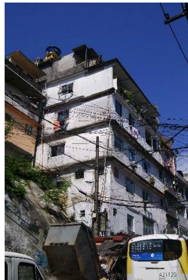
Figura 98: extensões de laje nas fachadas. Março/2013. foto da autora.
