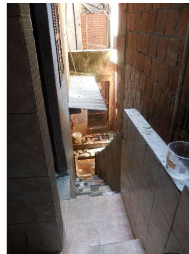
Figura 91: visão da escada de acesso ao segundo pavimento. jul/2016. foto da autora.
