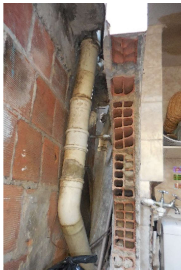
Figura 97: vão estreito existente entre as construções. Março/2013. foto da autora.
