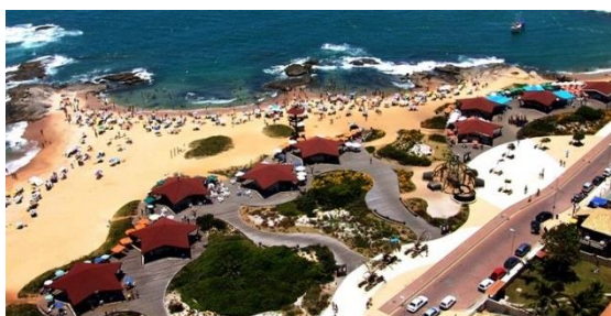
Orla de Costa Azul após obra de reurbanização
