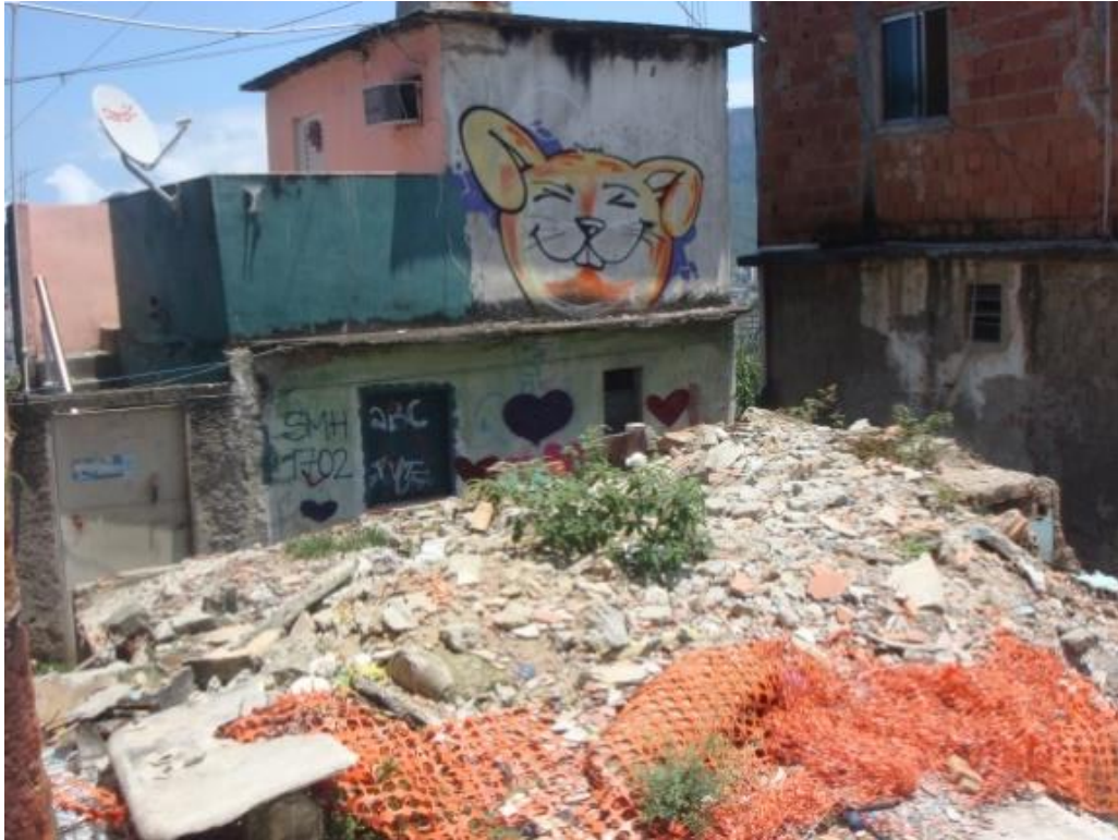
Figura 18 - Casa demolida antes da paralização das obras. Fonte: BORGHEZAN, 2013.
