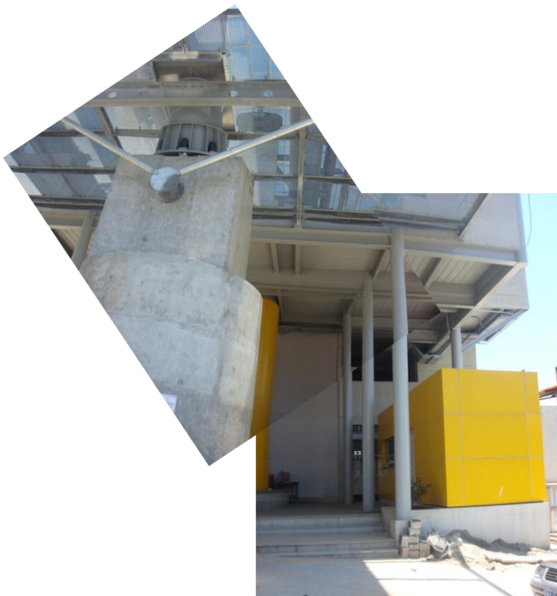
Figura 36 - Teleférico do Morro da Providência montagem 2. Fonte: BORGHEZAN, 2013.
