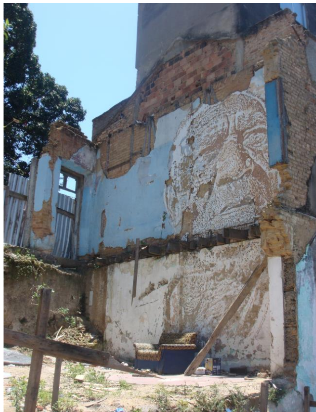
Figura 19 - Casas demolidas para a construção do Plano Inclinado, que não foi construído por conta da paralização das obras, o rosto esculpido do antigo morador é parte do trabalho realizado por Vihs, a fim de resgatar a memória daquele lugar. Fonte: BORGHEZAN, 2013.
