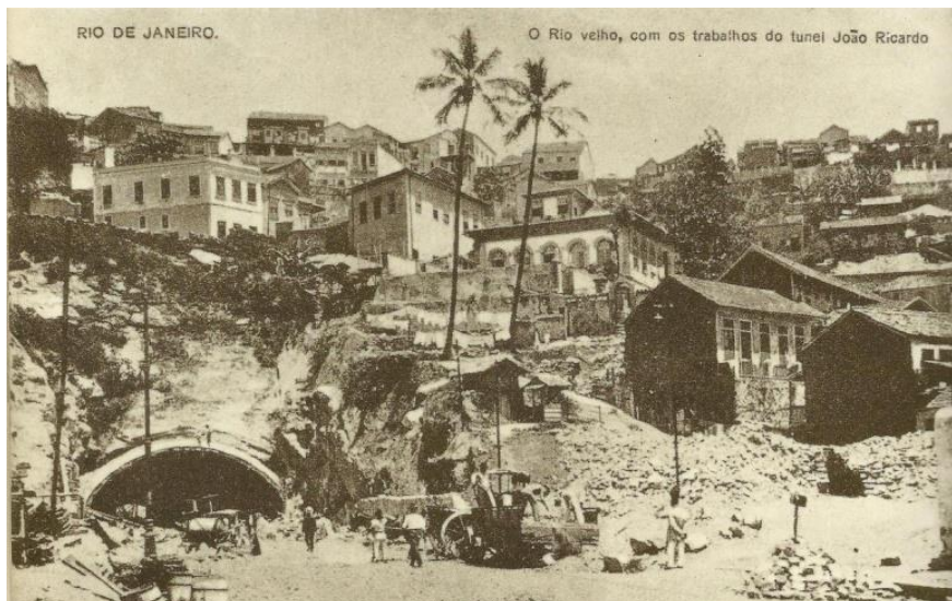
Figura 12 - Morro do Livramento, abertura do Túnel João Ricardo, concluída em 1922. Fonte: CARDOSO et al, 1987, p. 94.
