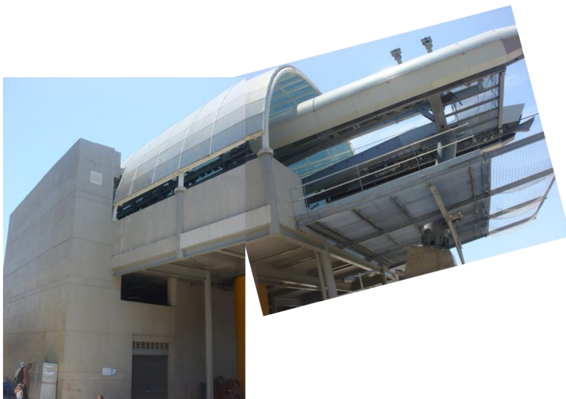
Figura 35 - Teleférico do Morro da Providência montagem 1. Fonte: BORGHEZAN, 2013.
