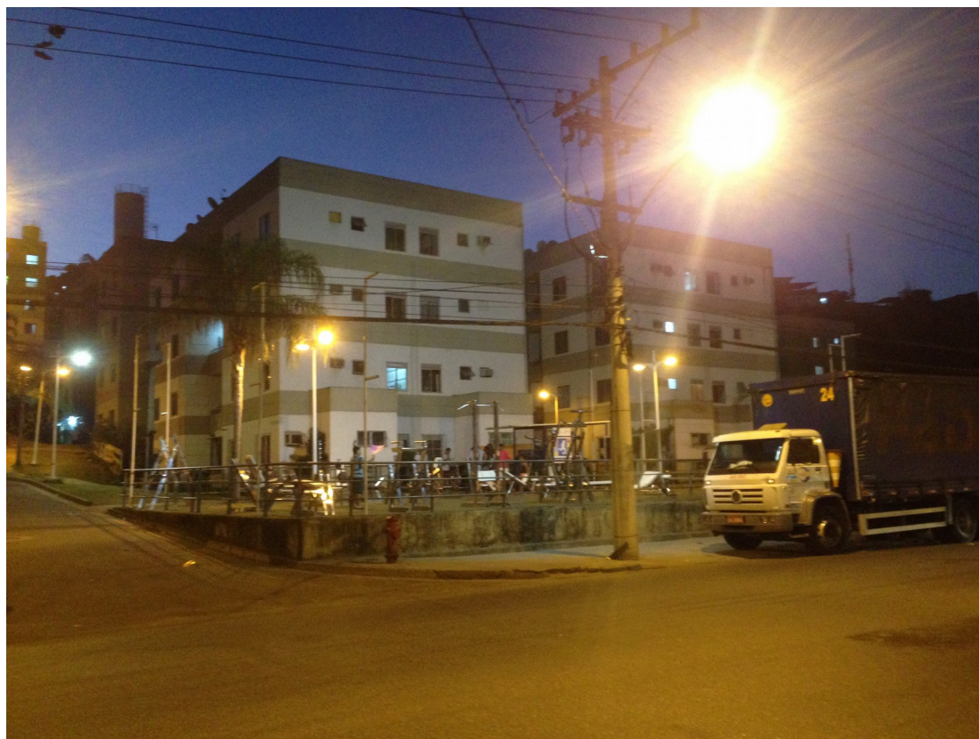
Figura 27: Conjunto MCMV na Estrada do Itararé, em Bonsucesso, erguido no âmbito do PAC
