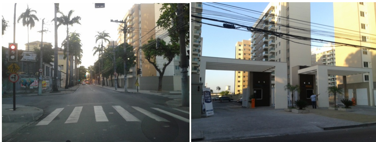
Figura 40: Fotos do condomínio construído
