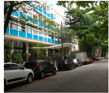
Ed. Nova Cintra, que implantado no alinhamento da rua existente, R. Gago Coutinho, com uma das faces voltadas para a rua e entradas e comércio no térreo, dão o caráter singular desse bloco em relação aos outros. Por esse motivo, aqui é considerado como o bloco que constrói a relação com a rua, a "fachada urbana" do projeto.
