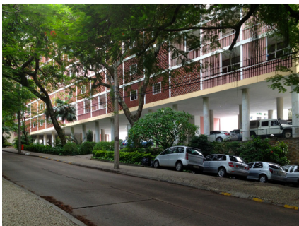
Ed. Caledônia e a continuação dessa fachada que configuram a borda, o limite, do Parque;
