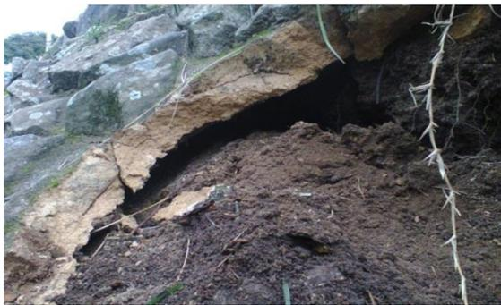
Figura 35: Grave trinca vertical na parede Sudoeste (indicado em D, na Fig. 34) e abaixo, situação de desagregação do solo abaixo do arrimo de pedras na base da Parede Oeste (indicado em F, na Fig. 34). Fonte: Acervo Ivo Barreto, 2012.
