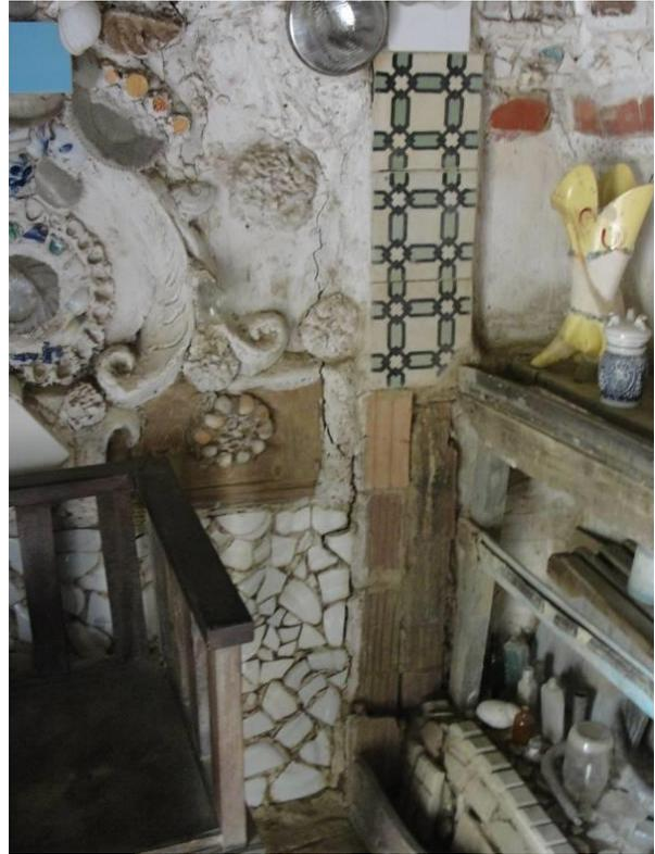
Figura 36: Repercussão da movimentação da fundação na ornamentação interna, com trincas severas e perda de peças. Fonte: Acervo Ivo Barreto, 2012.
