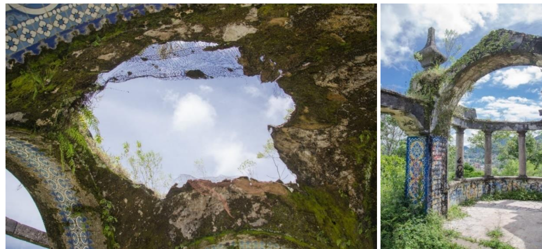
Figura 55 - Estado atual das coberturas
