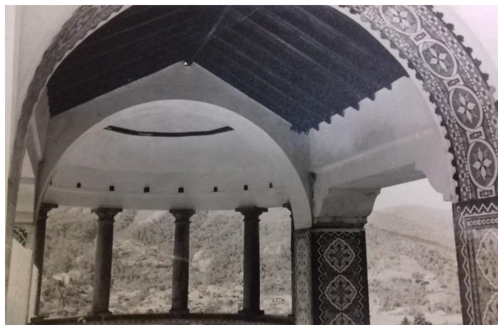
Figura 120 - Cobertura e forros originais - Vista leste Foto sem data - Acervo Casa da Memória Arthur Dalmasso.
