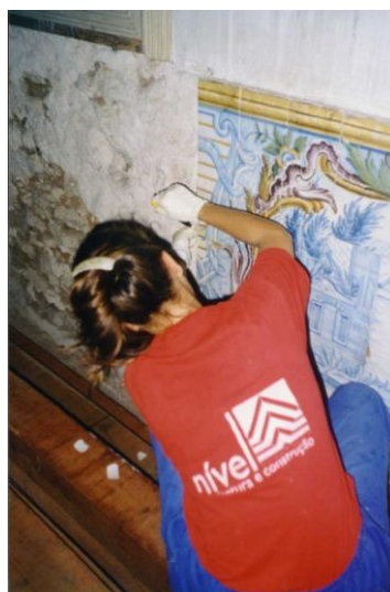
Figura 92 - Ausência de um dos painéis de azulejo - Igreja N. Sra. da Saúde Fonte: Arquivo cedido Prof. Jorge Astorga
