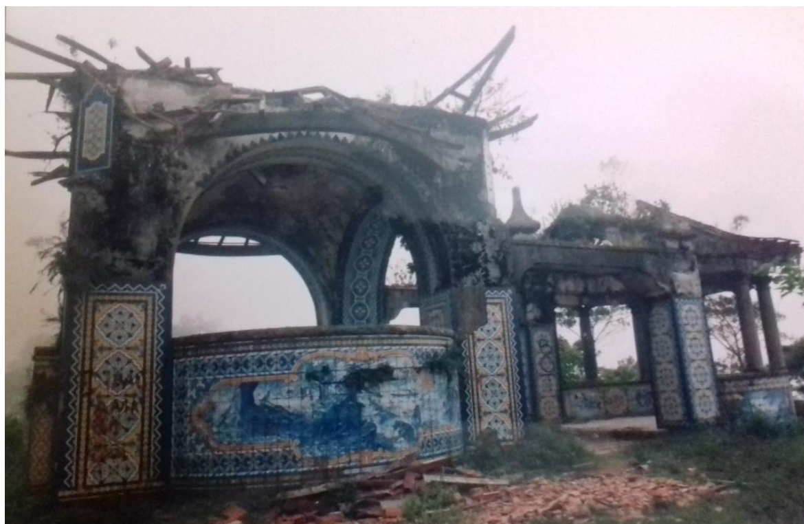
Figura 16 - Desabamento das coberturas do Mirante, 1996. Fonte: Acervo Casa da Memória Arthur Dalmasso. Julho/ 2016
