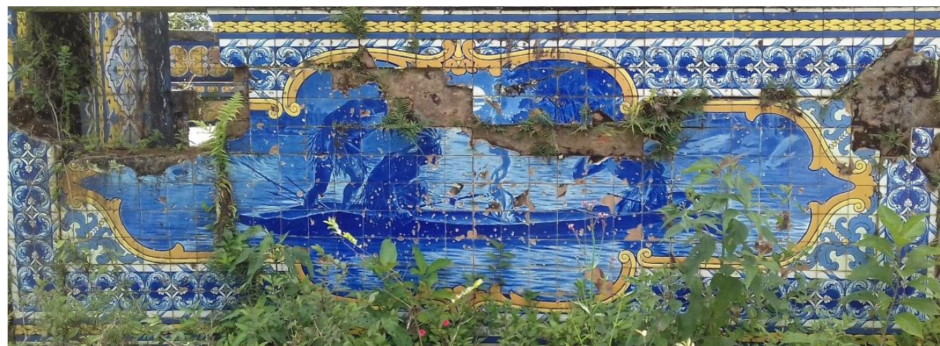
Figura 101 - Estado atual - Painel 01
