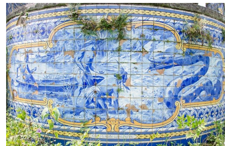
Figura 102 - Estado atual - Painel 02
