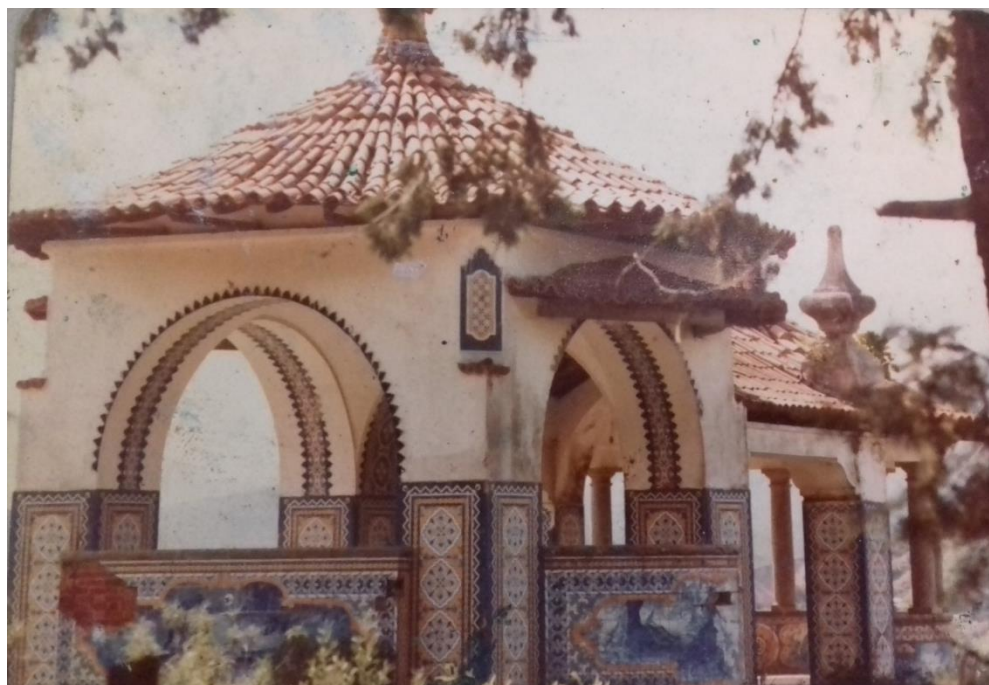
Figura 14 - Mirante ainda com suas coberturas. Década de 1980. Fonte: Acervo Casa da Memória Arthur Dalmaso. Julho/ 2016
