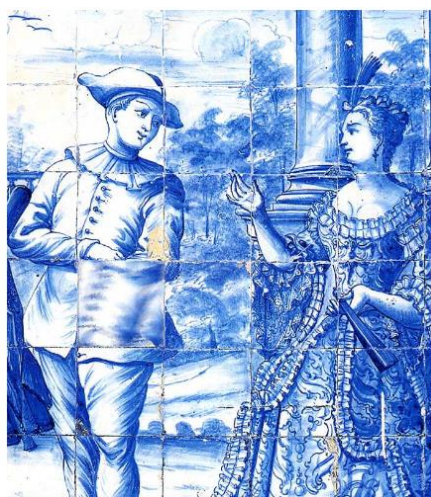
Figura 88 - Reintegração de lacuna em painel por substituição de elemento abstrato. Fonte: (MIMOSO, 2009)
