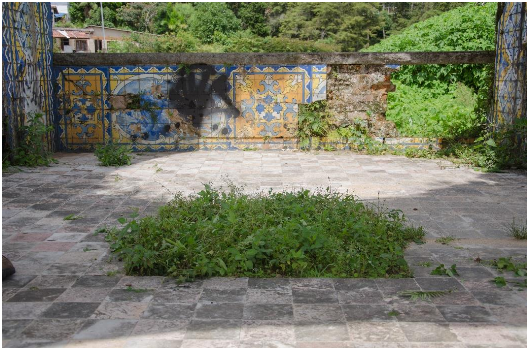
Figura 24 – Local da antiga fonte no Mirante das Lendas. Foto da autora em Janeiro/ 2017.
