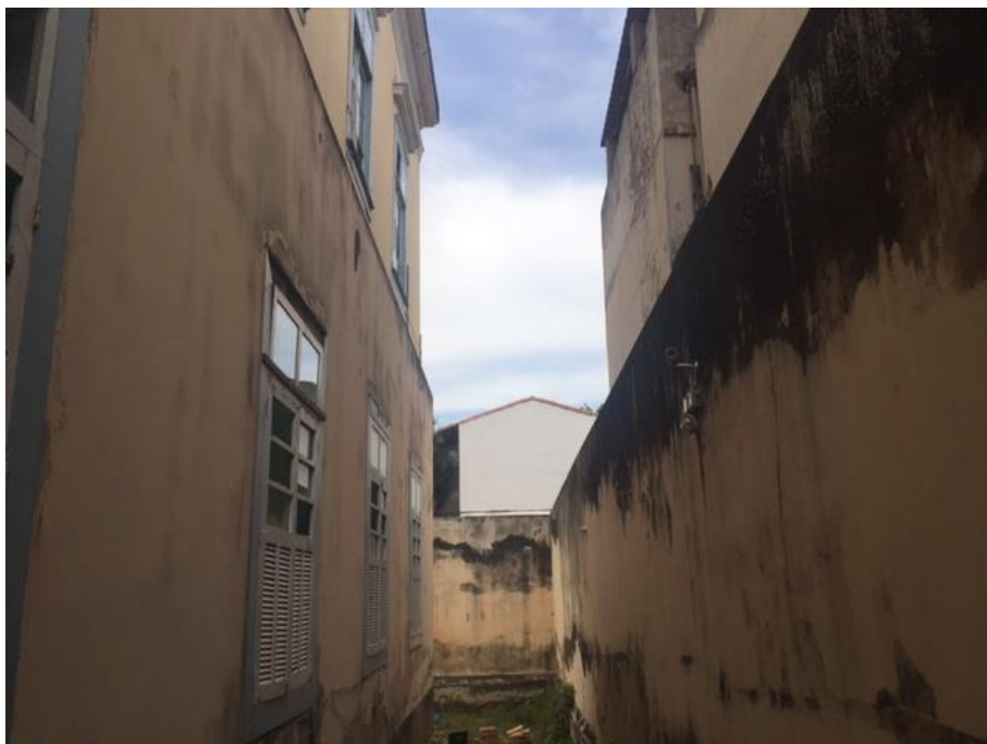
Figuras 8: Casa Barão do Ribeirão e construções vizinhas.
