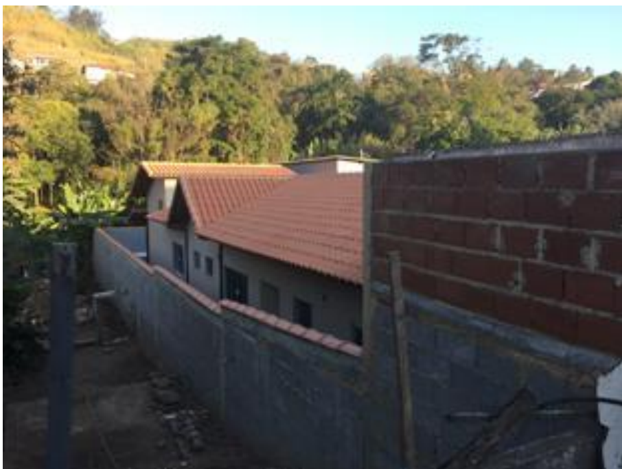
Figuras 5: Anexo irregular – Centro Histórico de Vassouras. Fonte: Keilla Miranda, 2016.
