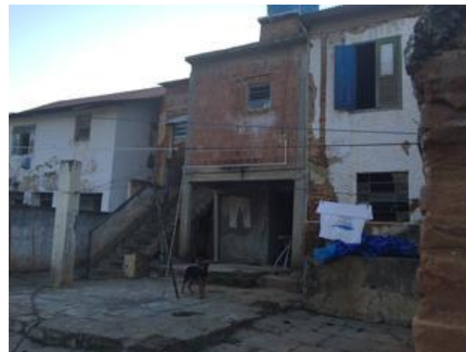
Figuras 6: Anexo irregular - Centro Histórico de Vassouras. Fonte: Keilla Miranda, 2016.
