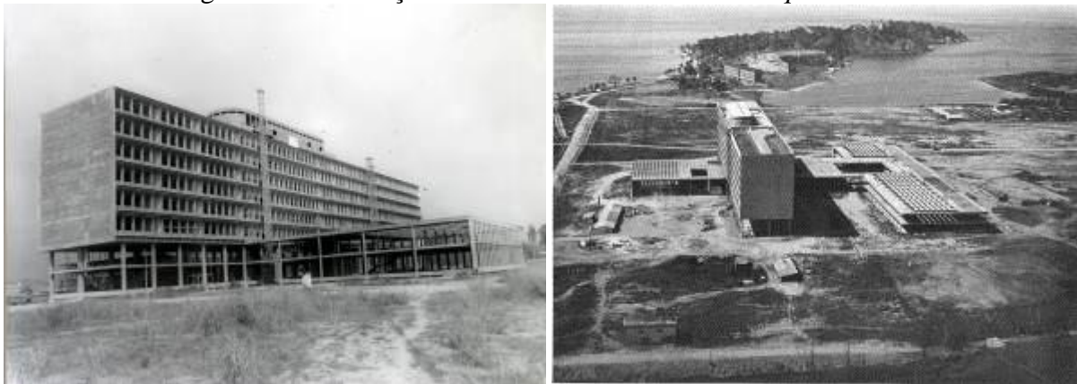
Figura 3 – Construção da Faculdade Nacional de Arquitetura 20
