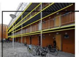
de klafra Architecten borne - Student housing The Hague, Passarelas conectam todos os blocos do edifício;
