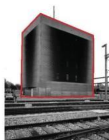
Signal Box / 1991-94 Herzog & De Meuron Basel, Suíça
