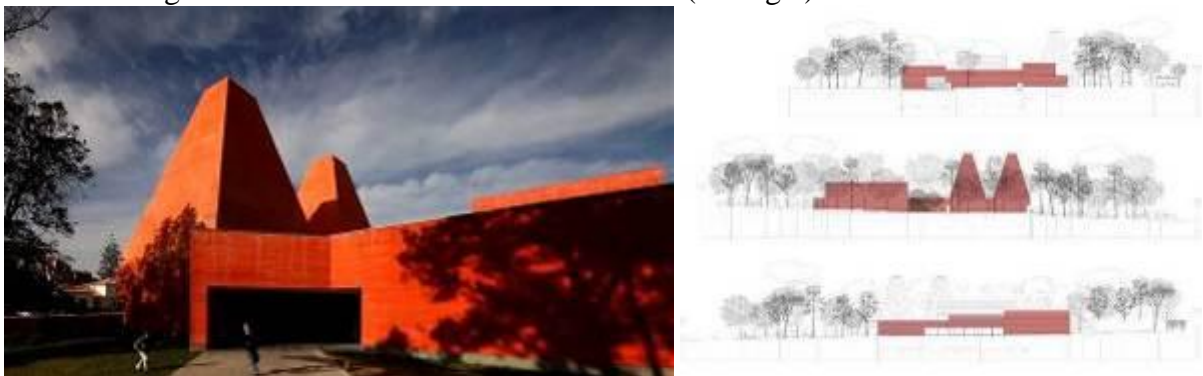
Figura 44 – Casa de Histórias em Cascais (Portugal) de Souto de Moura
