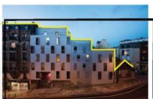
Paris XX, Mentimont - Sabotik & Masson, o edifício se relaciona com os vizinhos com uma gradação de gabarito e marcação de testada;
