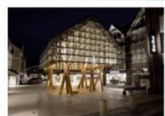
Referência de priorização do espaço público através do uso de pilotis, permitindo conexão visual entre diferentes ambientes. Lantern Pavilion, Sandnes, Noruega Projetado por: AWP/Atelle Oslo, em 2008
