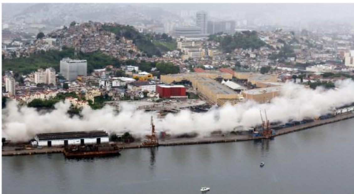
Figura 19 - A Implosão do Elevado da Perimetral em 24/11/2013
