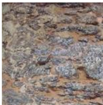
Figura 105 - Parede de Pedra e Cal, lote 147
