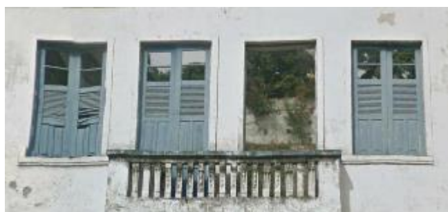
Figura 107 - Esquadrias do pavimento superior, lote 143
