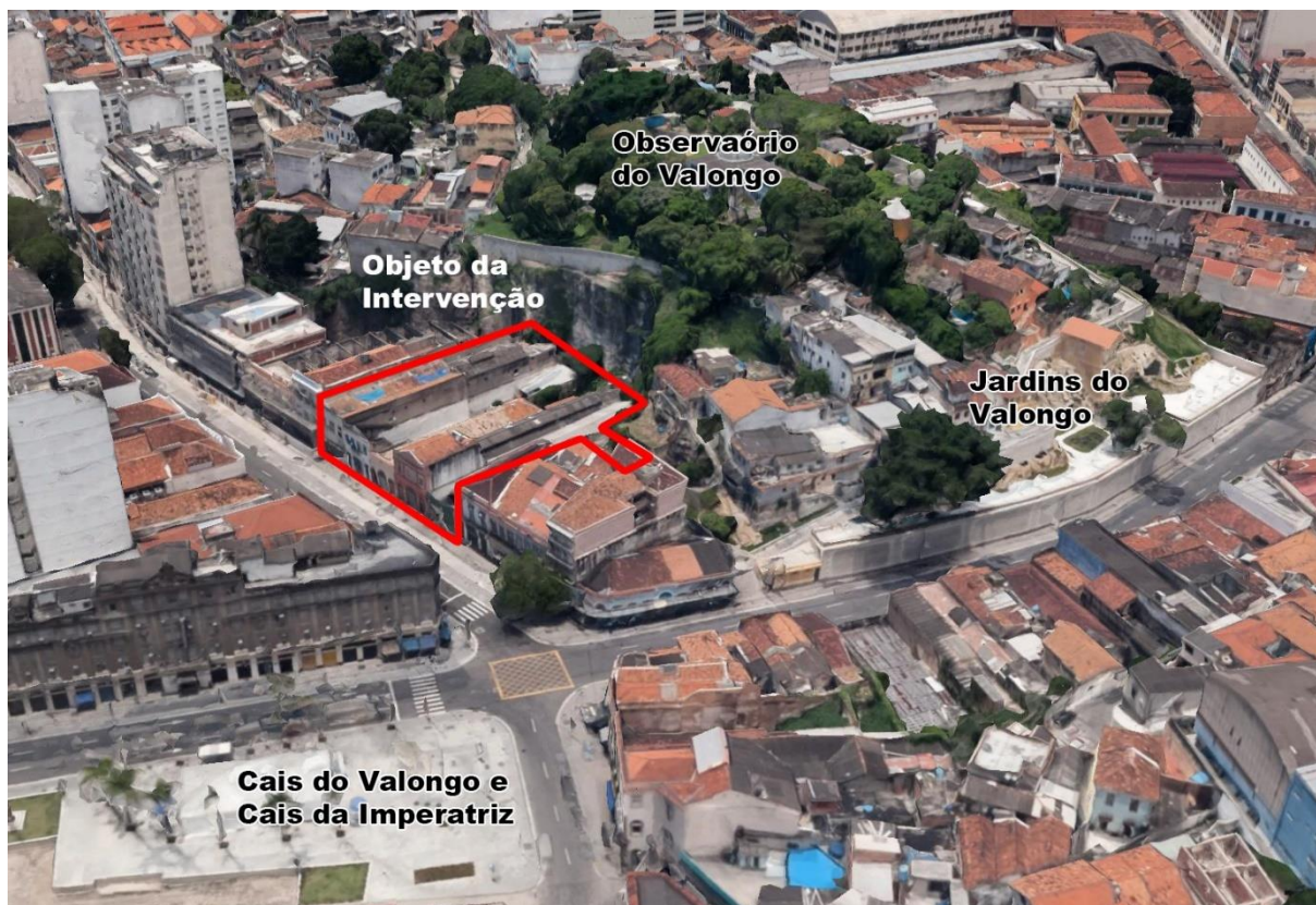
Figura 65 - Vista aérea do entorno
