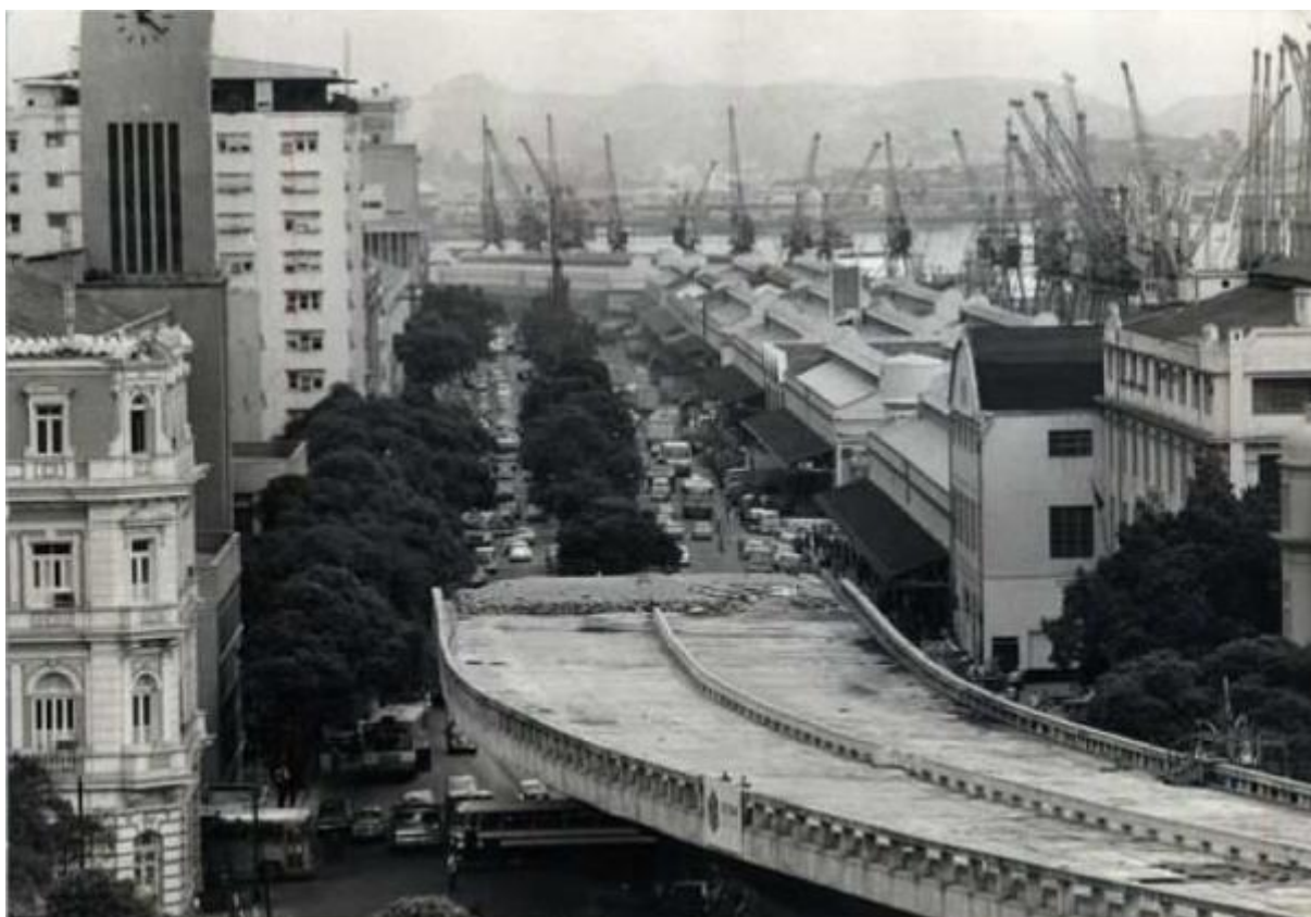
Figura 18 - Construção da segunda etapa do Elevado da Perimetral Passando por cima da atual Praça Mauá.
