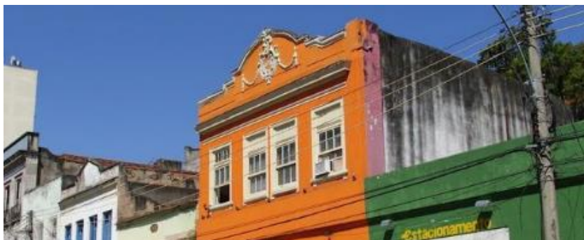
Figura 110 - Platibandas do conjunto, lotes 141, 143, 145, 147 e 149
