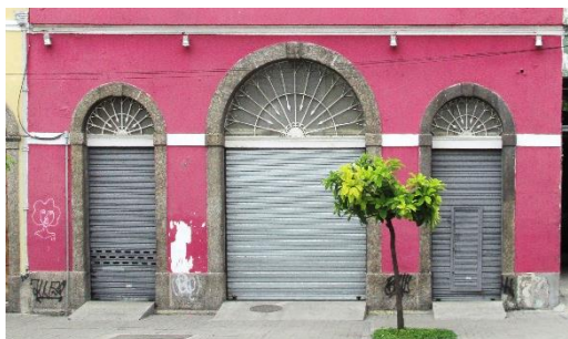
Figura 108 - Esquadrias do pavimento inferior, lote 147
