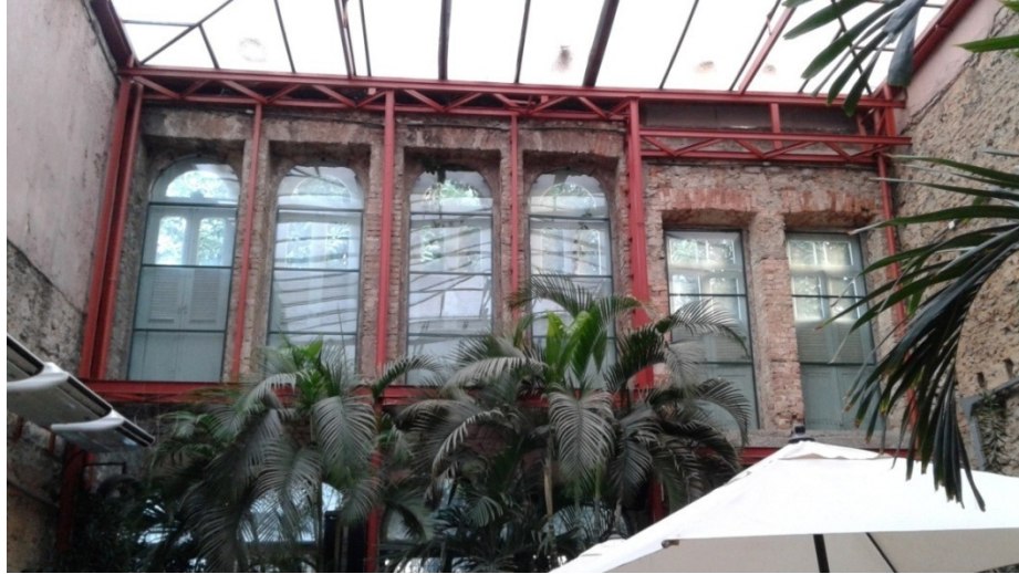
Fig. 16 - Intervenção realizada em edificação da Rua do Mercado. Fonte: LIMA CARLOS, Claudio Antonio S. Agosto/2016
