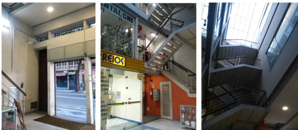
Figura 19 - Interior de edificação do Corredor Cultural localizada na Rua da Carioca. Percebemos que a fachada é mera cenografia, e seu espaço interior não corresponde à arquitetura original. Foto da autora: 05/07/2017.
