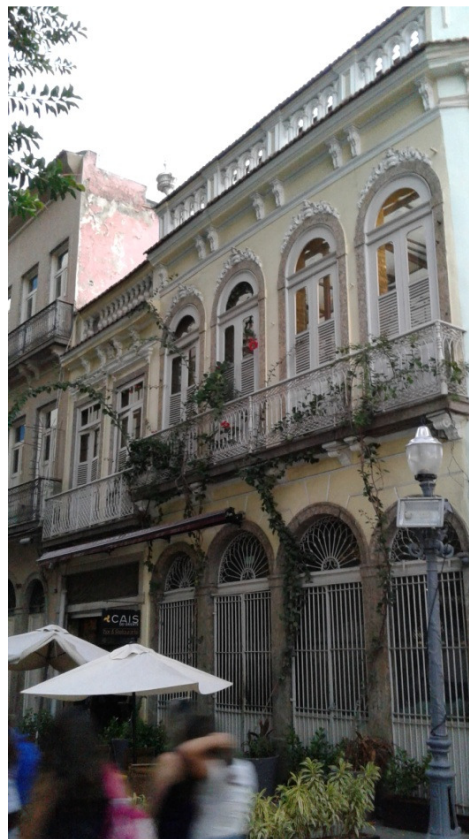
Fig. 17 - Edificação da Rua do Mercado, exemplificando o chamado “fachadismo”. Fonte: LIMA CARLOS, Claudio Antonio S. Agosto/2016
