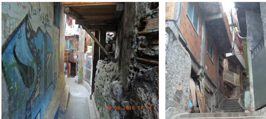
FIGURA 100 - FOTOS COM EXEMPLOS DE SACADAS COBRINDO A CIRCULAÇÃO EXTERNA.
