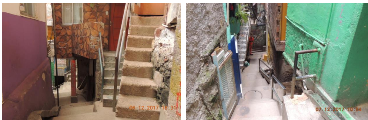
FIGURA 101 - FOTOS COM EXEMPLOS DE ESCADAS DE ACESSOS PARA AS RESIDÊNCIAS.
