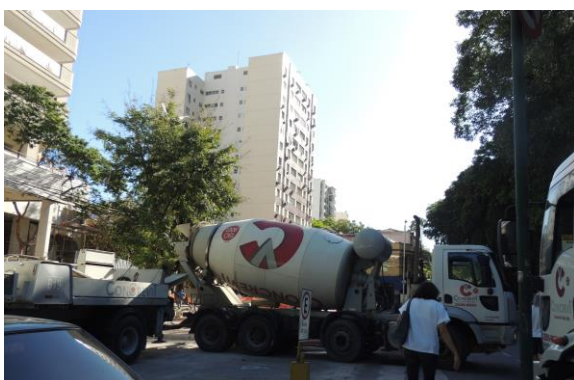
FIGURA 108 - FOTO DA OBRA NA ZONA 15.
