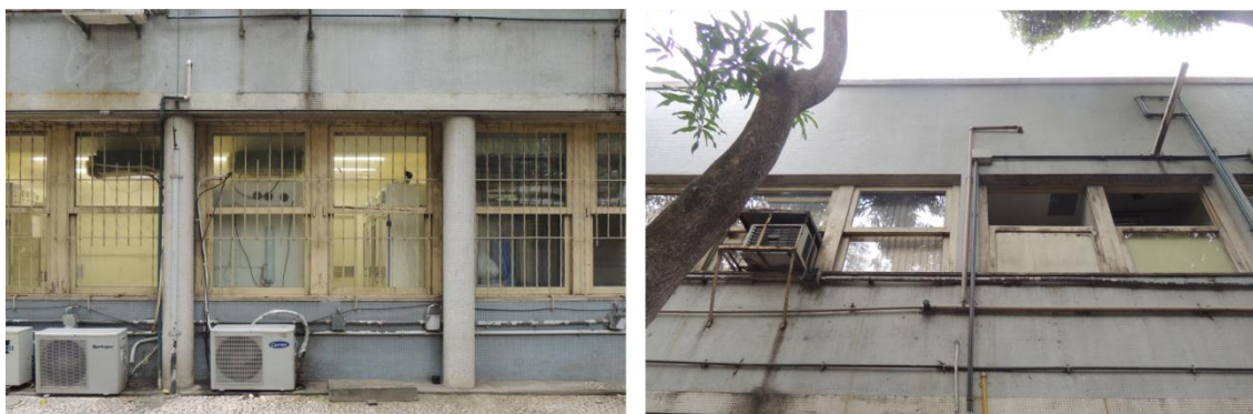
Figura 54 - Elementos espúrios - Fachada Sudeste (Nayara Gevú, 2017)
