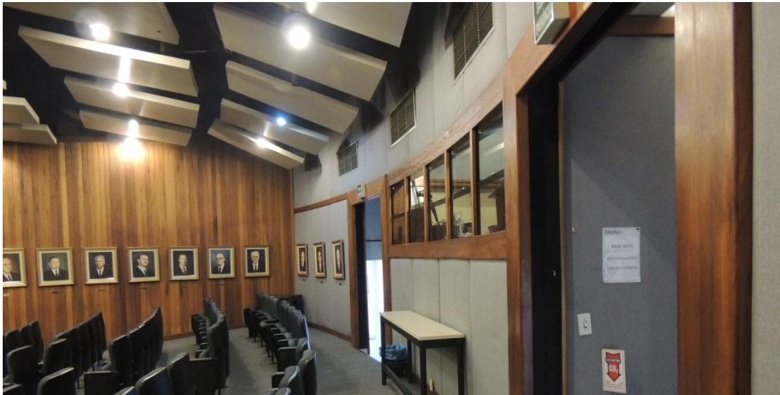
Figura 83 - Vãos de entrada Auditório (Nayara Gevú, 2017)
