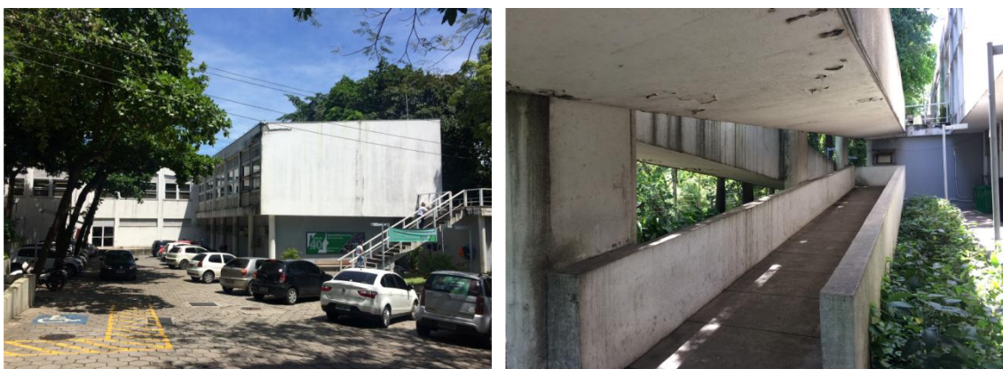
Figura 14 - Fachada Posterior e Rampa - Pavilhão do Refeitório (Nayara Gevú, 2016)
