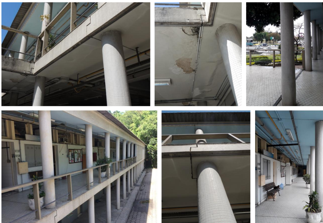
Figura 41 - Juntas de união e dentes Gerber (Nayara Gevú, 2017)
