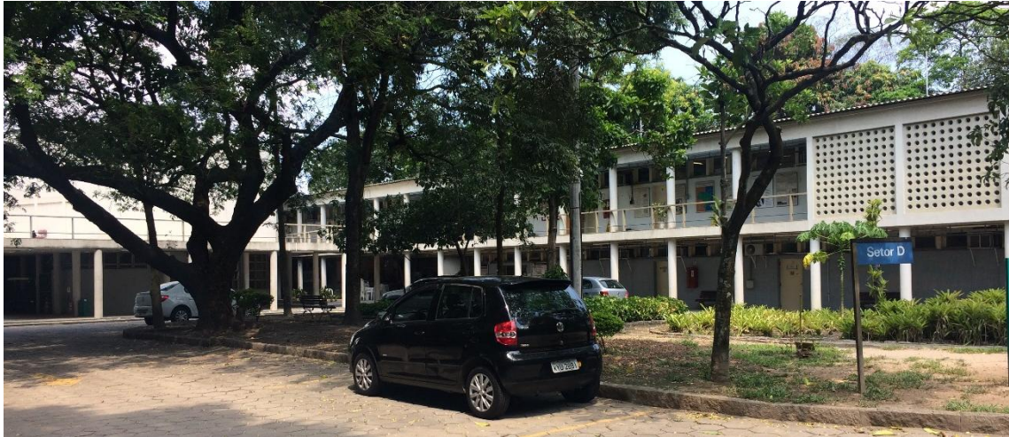
Figura 35 - Pavilhão Arthur Neiva - Fachada principal do bloco retilíneo (Nayara Gevú, 2017)
