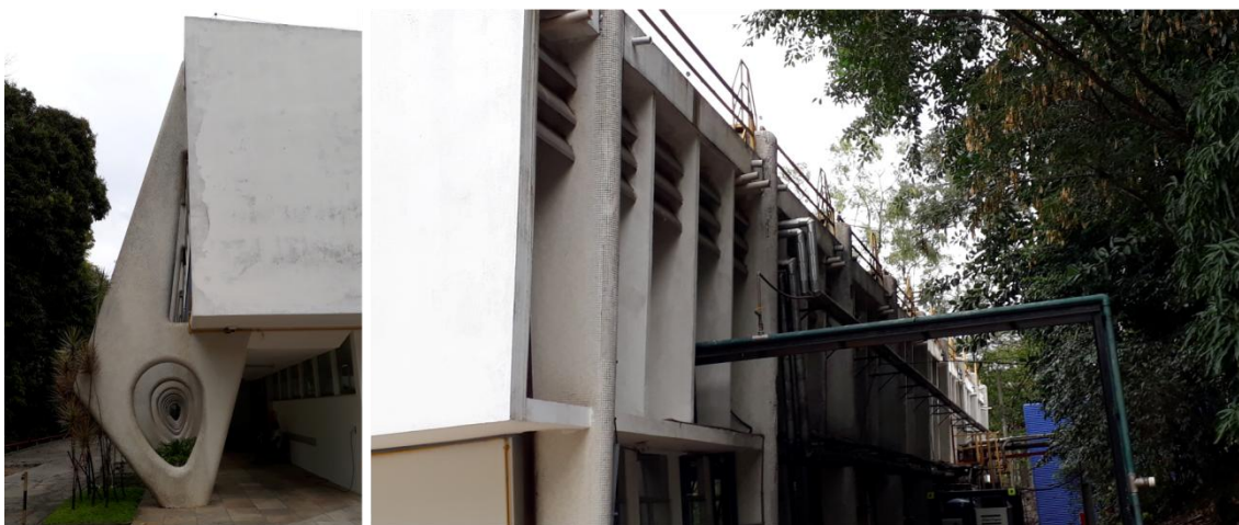
Figura 18 - Pilotis e Fachada Posterior do Pavilhão Henrique Aragão (Nayara Gevú, 2017)
