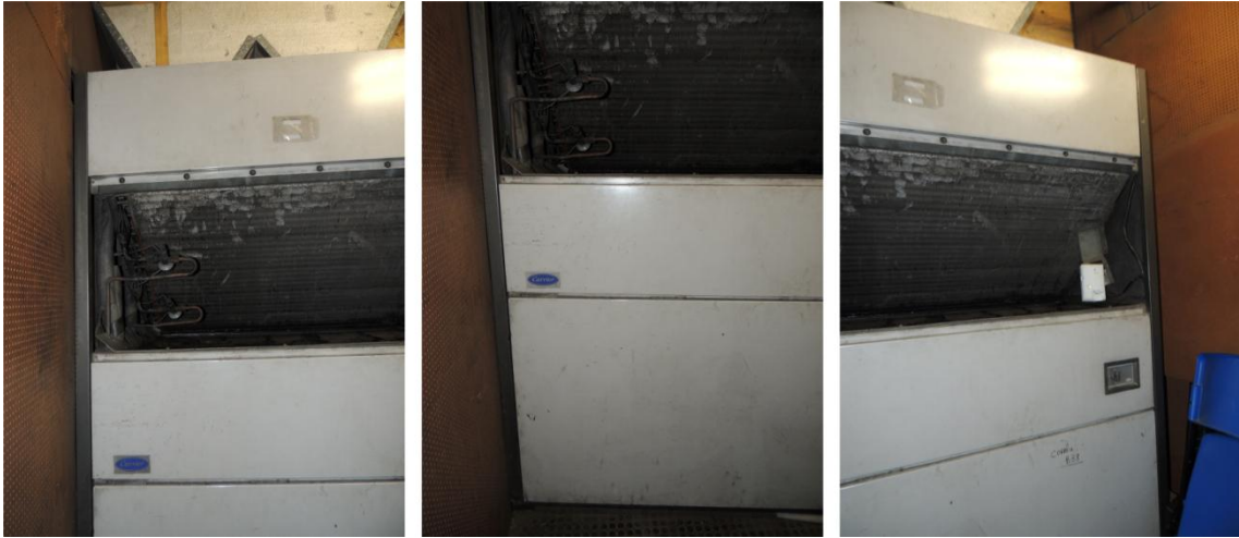
Figura 80 - Equipamento AC | Casa de Máquinas (Nayara Gevú, 2017)
