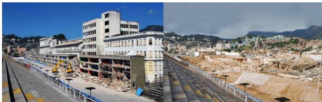
Figura 47 – Demolição parcial do sambódromo. Disponível em: http://ultimosegundo.ig.com.br/brasil/rj/implosao+de+antiga+fabrica+na+sapucaia+durou+23+segundos/n1597004328870.html . Acesso em: 20 jul. 2015.
