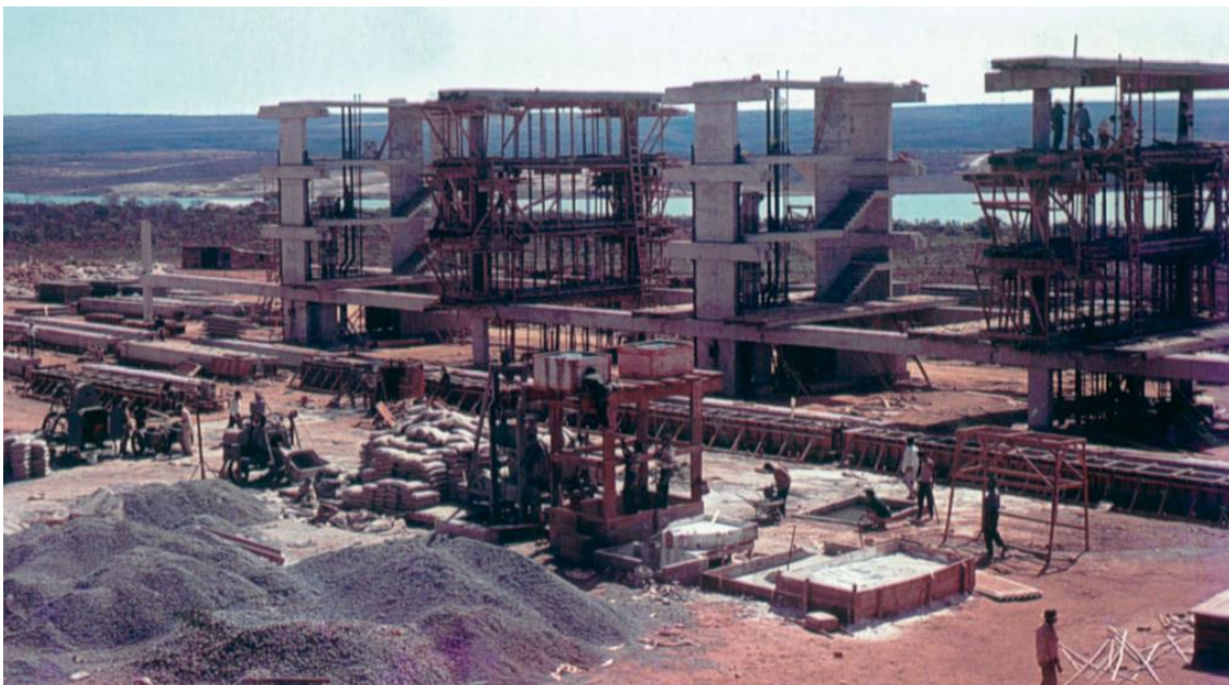
Figura 27 – Construção do conjunto de edifícios habitacionais “Colina” para os servidores da UnB. João “Lelé” Filgueiras Lima, arquiteto. [196-]. Disponível em < www.flickr.com/photos/unb_agencia/34320012775 >.
