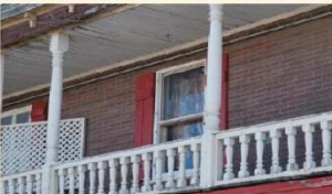
Les colonnes et le garde-corps en bois ouvragé. (Source : Ville de Montréal, avril 2014)
