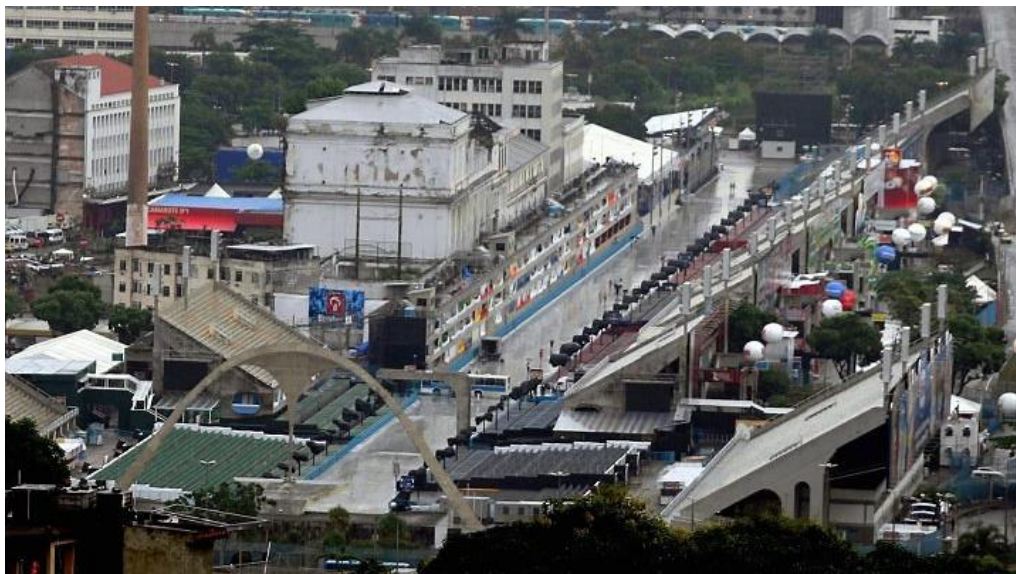
Figura 46 – Sambódromo antes da demolição parcial. Disponível em: < www.rhbn.com.br/uploads/docs/images/images/sambodromo%2002.jpg >. Acesso em: 20 jul. 2015.
