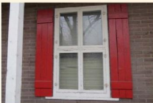
Fenêtre à battants en bois d'origine. Les contrevents points en rouge ont été ajoutés après 1981. (Source : Colin Fraser, architecte, février 2014)
