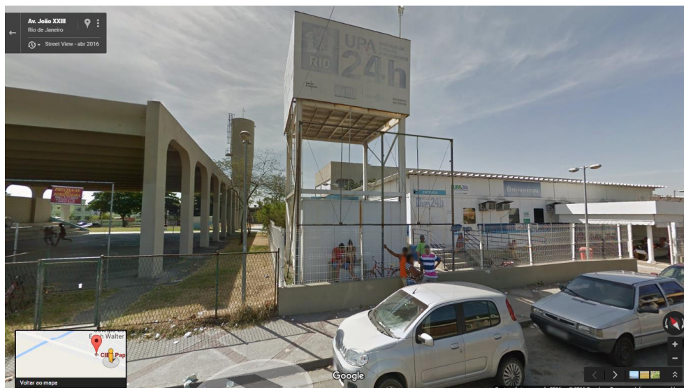
Figura 74 – UPA em terreno do CIEP Papa João XXIII, Santa Cruz. Fonte: Google Maps, 2016.
