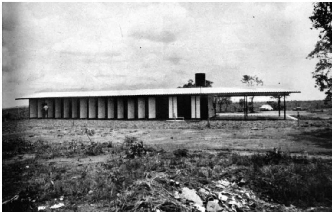
Figura 39 - Protótipo da Escola Transitória, Abadiânia, Goiás. João ‘Lelé’ Filgueiras Lima, arquiteto. (1983). Disponível em: LIMA, 1984, p. 27, foto 14.
