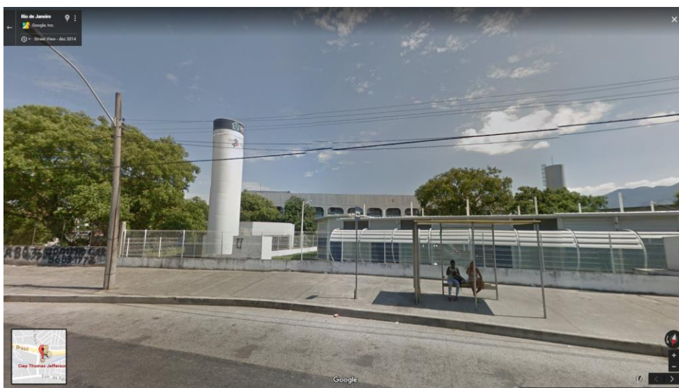
Figura 81 – Inserção de edifício no terreno do CIEP Thomas Jefferson Realengo. Fonte: Google Maps, 2014.
