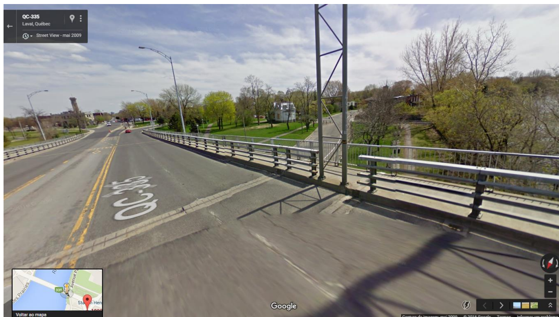
Figura 5 – Imóvel 10905, rue Berri. Antiga clínica Ahuntsic vista da ponte Viau, Ahuntsic-Cartierville, Montreal, Canadá. Fonte: Google Maps, maio 2009.
