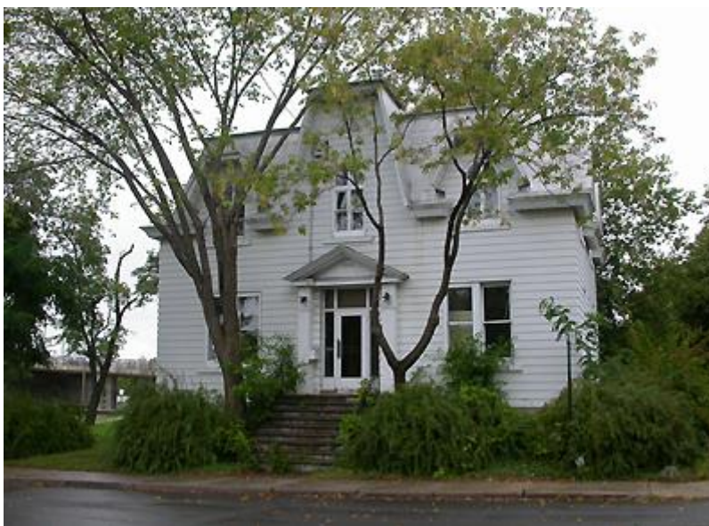
Figura 4 – Imóvel 10905, rue Berri. Antiga clínica Ahuntsic, Ahuntsic-Cartierville, Montreal, Canadá. Foto: Ville de Montréal. 2007. Disponível em: < http://patrimoine.ville.montreal.qc.ca/patri_municipal/icono/grand/AC005855.jpg >.
