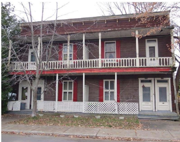
2118-2124, boulevard Gouin Est. (Source : Colin Fraser, architecte, février 2014)
