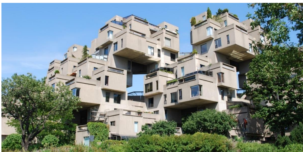
Figura 21 – Habitat 67, Montreal, Canada. Moshe Safdie, arquiteto. (1967). Disponível em: < https://upload.wikimedia.org/wikipedia/commons/9/91/Montr%C3%A9al_-_Habitat_67_(04).jpg >.
