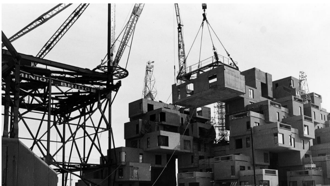
Figura 23 – Construção Habitat 67, Montreal, Canada. Moshe Safdie, arquiteto. (1967). Disponível em: < http://assets.dwell.com/sites/default/files/2012/12/22/peart-weisgerber-habitat-67-construction.jpg >.
