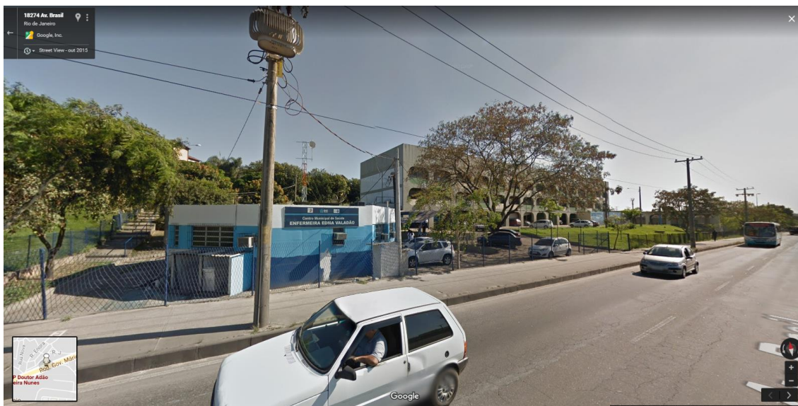
Figura 82 – Biblioteca do CIEP Doutor Adão Pereira Nunes, Irajá, transformada em Centro Municipal de Saúde Enfermeira Edna Valadão, com estacionamento dentro do terreno da escola. Fonte: Google Maps, out. 2015.
