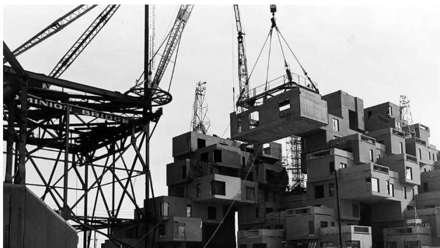
Figura 30 – Construção Habitat 67, Montreal, Canada. Moshe Safdie, arquiteto. (1967). Disponível em: < http://assets.dwell.com/sites/default/files/2012/12/22/peart-weisgerber-habitat-67-construction.jpg >.
