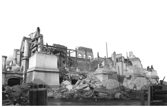
Fig. 32 | Fachada principal do Palácio Monroe sendo demolida em 1976. FONTE: Agência O Globo.
