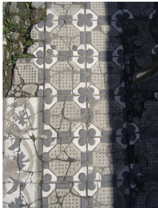
Fig. 71 | Detalhe do ladrilho hidráulico da calçada em 2013. FONTE: Processo nº 1104/1994.
