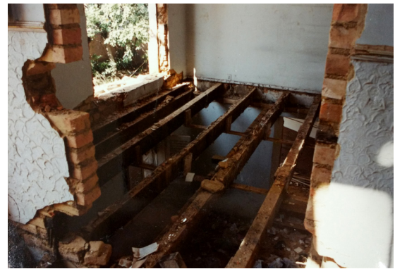
Fig. 61| Retirada dos pisos de madeira. FONTE: Processo nº 1104/1994.
