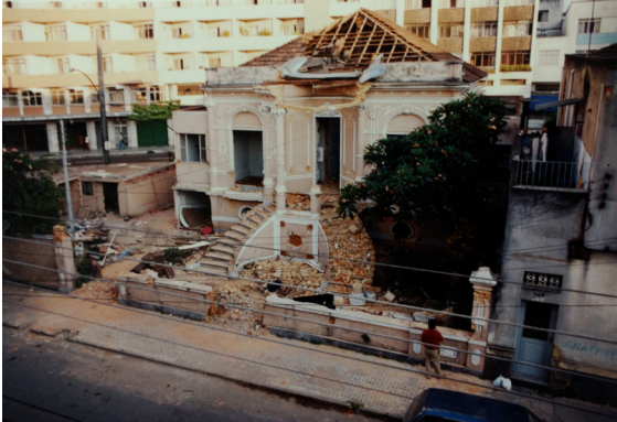
Fig. 58| Retirada de partes do telhado e portões. FONTE: Processo nº 1104/1994.
