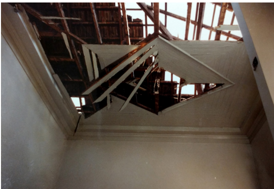
Fig. 60| Retirada do forro de madeira. FONTE: Processo nº 1104/1994.
