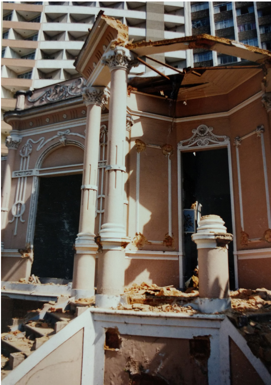
Fig. 62| Retirada dos forros de madeira, apoios e cobertura da varanda. FONTE: Processo nº 1104/1994.
