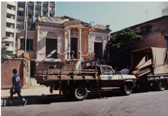
Fig. 54 | Demolição clandestina do Palacete Fellet - Registro fotográfico de 11/02/1994. FONTE: Processo nº 1104/1994.
