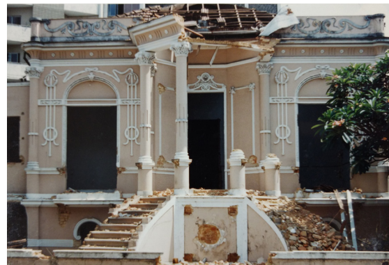
Fig. 55 | Retirada de elementos ornamentais e esquadrias. FONTE: Processo nº 1104/1994.
