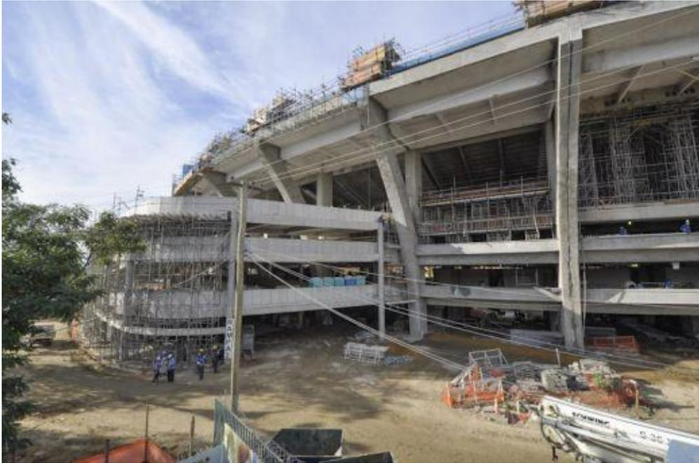
Figura 16 - Operários construindo uma das duas novas rampas do Maracanã. Fonte: fimdejogo.com.br, 2013
