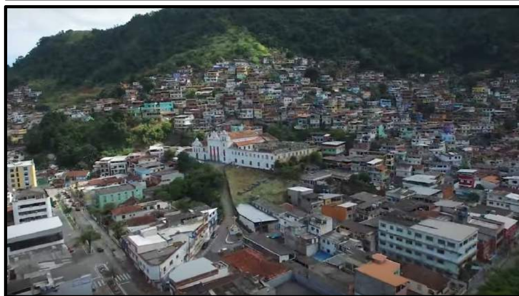
Figura 28 – Vista área do entorno do Convento São Bernardino de Sena em dois momentos: na década de 1920, fonte Acervo Manoel de Barros Souza e em 2017, fonte VBC imagens aéreas. Observa-se a trajetória da ocupação das quadras vizinhas ao Morro Santo Antônio a partir do Rio do Choro (atrás da Igreja Matriz)
