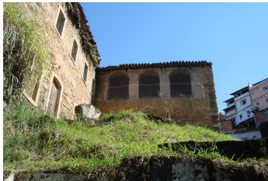
Figura 50 – T, Vista a partir do nível mais baixo para os vãos da escada que dá acesso ao pavimento superior do Convento, acervo da autora, 2011.
