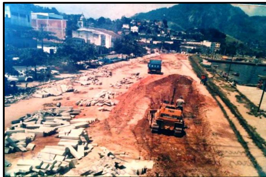
Figura 24 – Obras para o aterro onde será a Avenida Júlio Maria. Década de 1980. Fonte: acervo Marcelo de Barros Souza.
