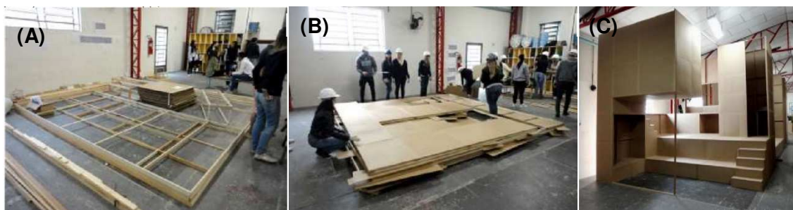
Figura 35 - (A) estrutura do mock-up ; (B) Painéis de madeira aguardando montagem; (C) Mock-up executado 1:1.
