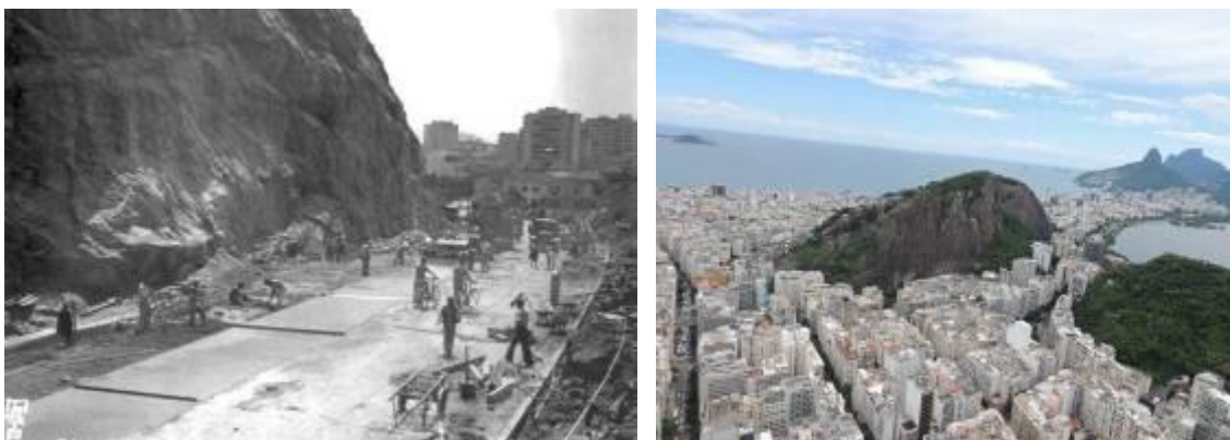
Figuras 72-a: À direita: obras de abertura do Corte do Cantagalo; à esquerda, corte do Cantagalo atualmente entre os bairros de Copacabana e Ipanema Fonte: SMU. PCRJ e Vera Tângari, 2016
