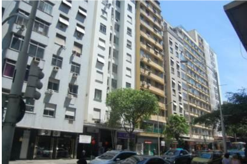
Figura 112: Tipo 1 – Recuado contínuo Fonte: Autor, 2018
