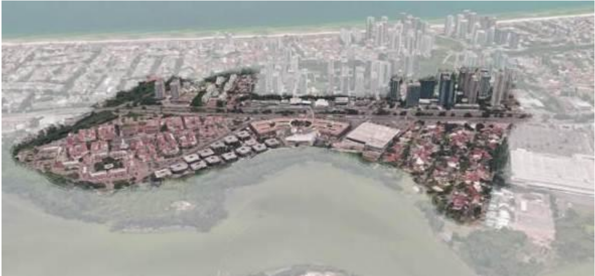
Figura 148-a; 148-b: Avenida das Américas - trecho trabalhado Fonte: Autor com base no GoogleEarth, 2018
