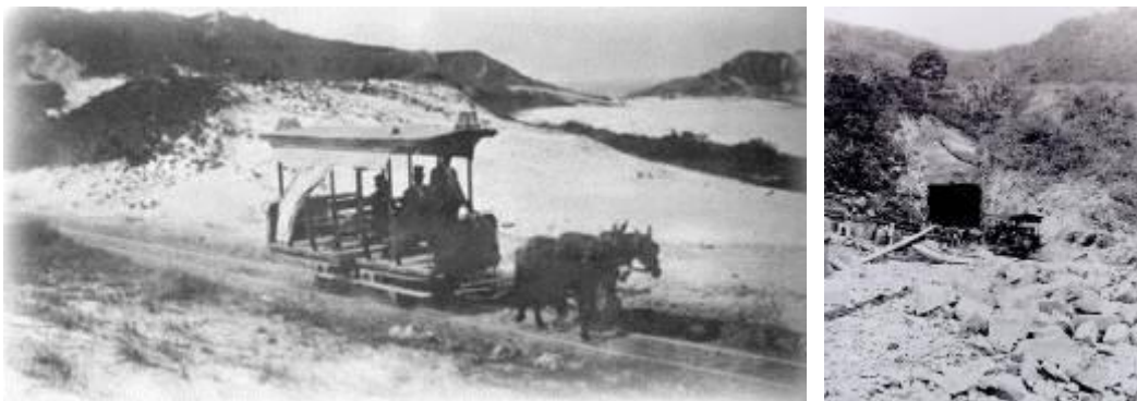
Figura 59 e 60: Abertura túnel velho e bonde puxado a burro
