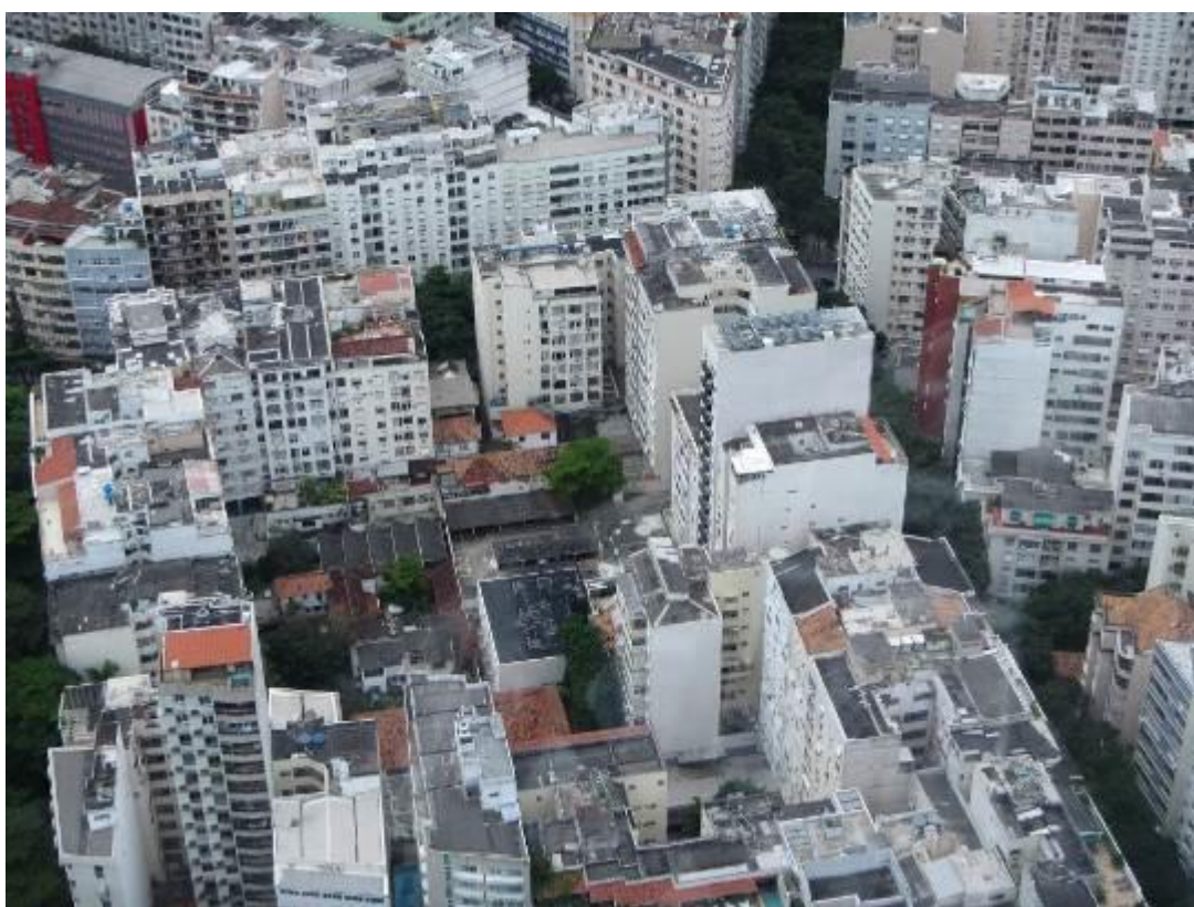
Figura 96: Detalhe de edificações no espaço livre intra-quadras Fonte: Silvio Macedo, 2016
