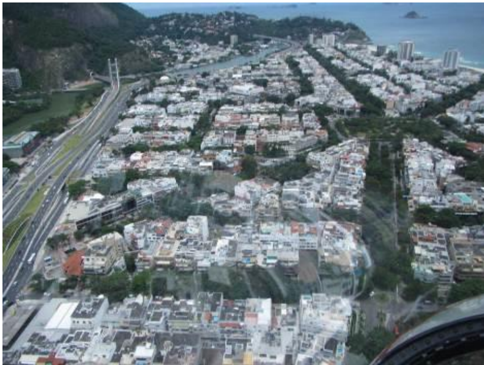
Figura 157: Edificações a sul no trecho estudado da Avenida das Américas Fonte; Silvio Macedo, 2016
