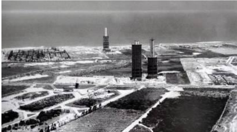
Figura 138: Em 1973, a construção das Torres do Condomínio Athaydeville, de Oscar Niemeyer, ainda em contraste com uma paisagem de pouca densidade Fonte: Paraisoocupado.com
