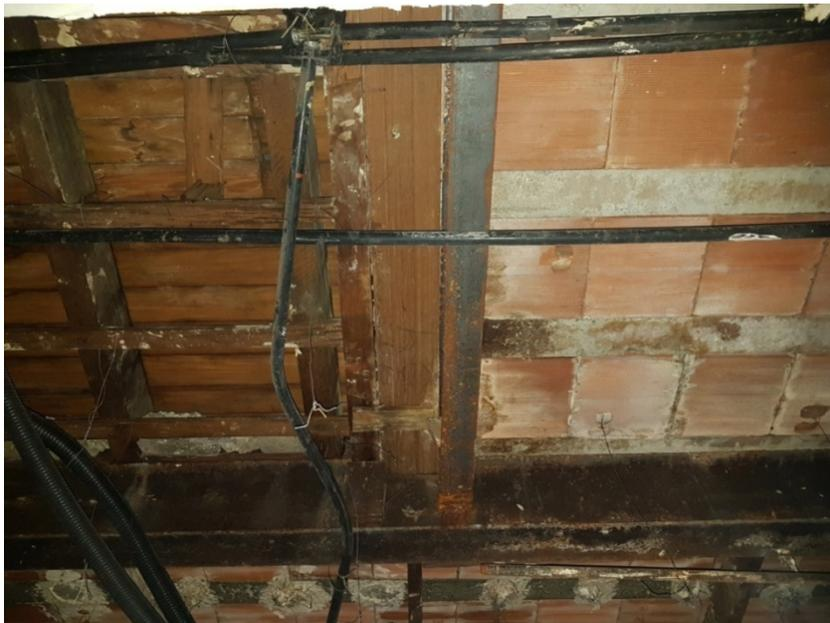
Figura 26- Na foto é possível observar o encontro dos dois métodos construtivos da laje que formou o 1º andar, concluído em 1966.
