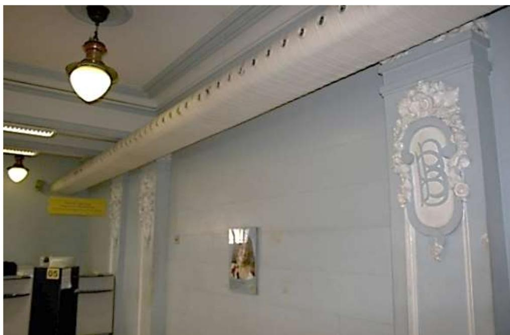
Figuras 56 - Dutos de ar condicionado interceptando esquadria da fachada frontal, no térreo e no andar superior, duto interceptando os ornatos existentes nos pilares.
