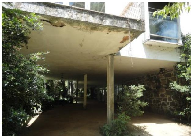
Figura 67: deterioração da cabeça da laje de acesso à varanda.
