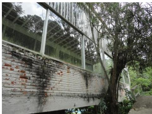
Figuras 68 e 69: vistas de trechos deteriorados como esquadrias metálica, beirais em telhas esmaltadas e alvenaria da varanda. Fonte: fotos do autor. Data: 2016.
