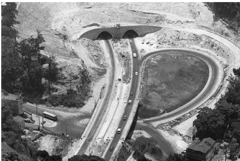
Figura 8 · Viaduto e alça do Túnel Rebouças recém construído, 1971.
