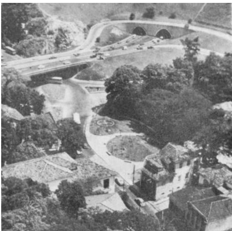
Figura 9 · Viaduto e alça do Túnel Rebouças, 1975.
