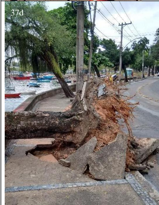
**Figura 37d:** Calçadas danificadas – aparentemente a partir do processo de erosão sofrido pela orla e pela inadequação da arborização.
