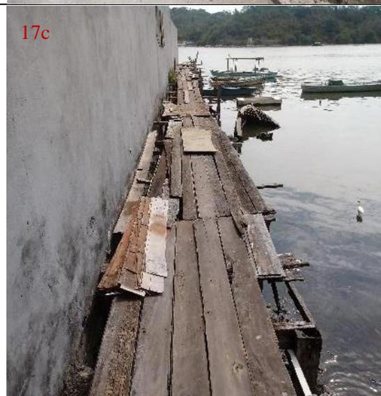
**Figura 17c**, temos uma estrutura em madeira improvisada utilizada para atracação de embarcações. O mau estado físico é visível e pode acarretar acidentes.
