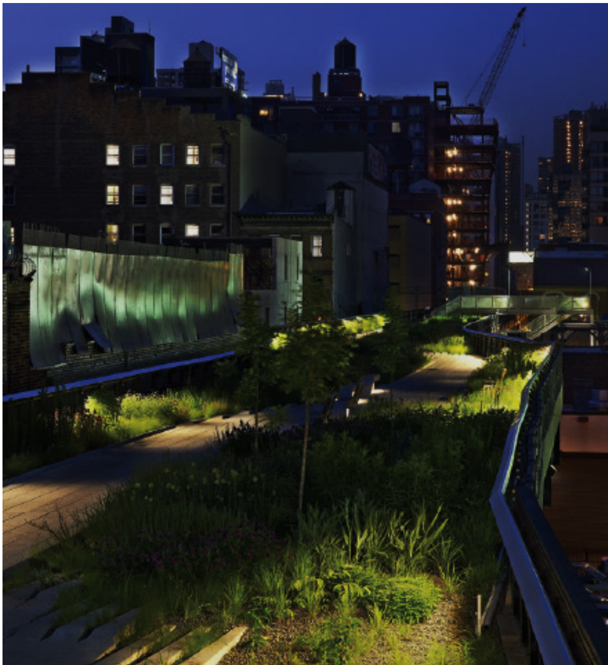
Fig. 10: Não obstruir a vista do céu teve como diretrizes: o uso de intensidades mais baixas, de luz, menor altura de instalação das fontes, além da omissão da luz emitida, direcionando-a para o piso. Projeto de Iluminação Urbana do High Line em Nova Iorque (2009-2014). Hervé Descottes/ L'Observatoire International . | Fonte: Descottes (2011).
