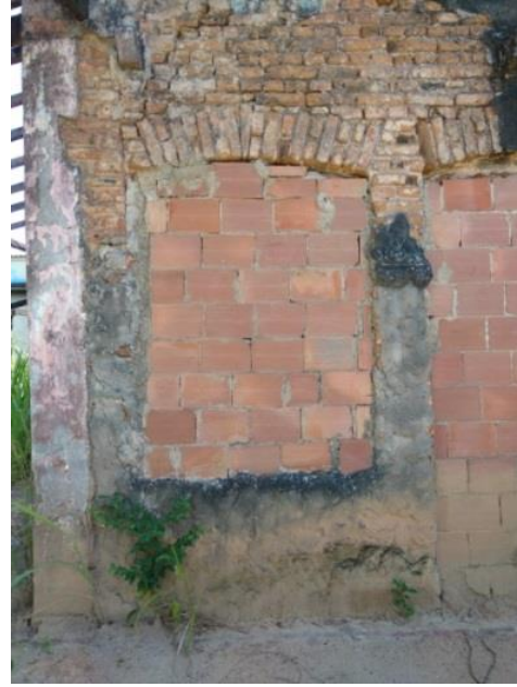
Figura 58 - Vão emparedado na fachada principal da edificação. Fonte: Fotografia da autora, 2016.
