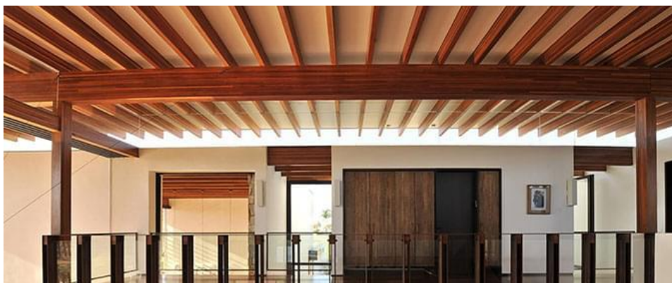
Figura 100 - Casa Baroneza, projeto de Candida Tabet Arquitetura, onde observa-se a utilização de MLC para vencer grandes vãos. Fonte: Fotografia de Rômulo Fialdini.
