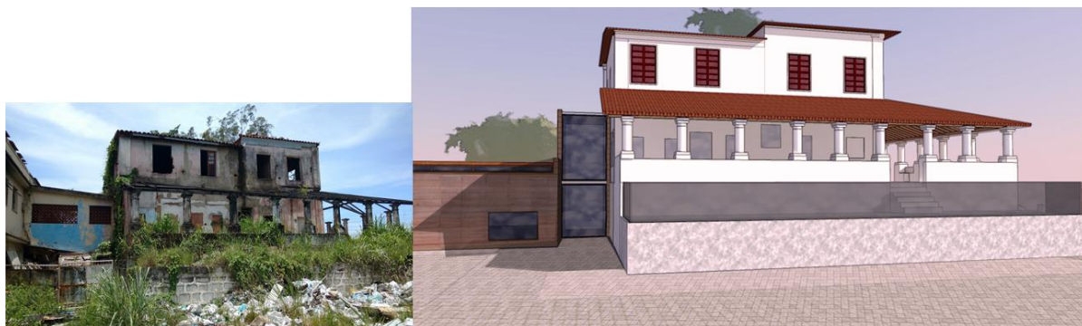
Figura 102 - Antes e Depois da conexão entre as duas edificações. Fonte: Fotografia da autora, 2017 e desenho da autora, 2018.
