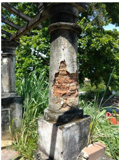
Figura 71 - Coluna de ordem toscana com parte da alvenaria exposta. Fonte: Fotografia da autora, 2016.
