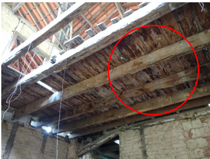
Figura 47 - Indícios da presença de insetos xilófagos nas madeiras do forro. Fonte: Fotografia da autora, 2016.
