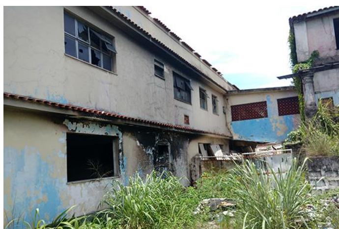
Figura 33 - Vista da conexão entre o anexo e a edificação Sede a partir do pátio. Fonte: Fotografia da autora, 2016.
