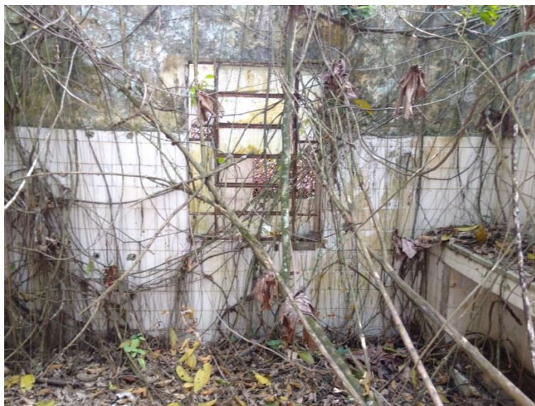
Figura 64 - Esquadria metálica existente no interior da edificação. Fonte: Fotografia da autora, 2016.
