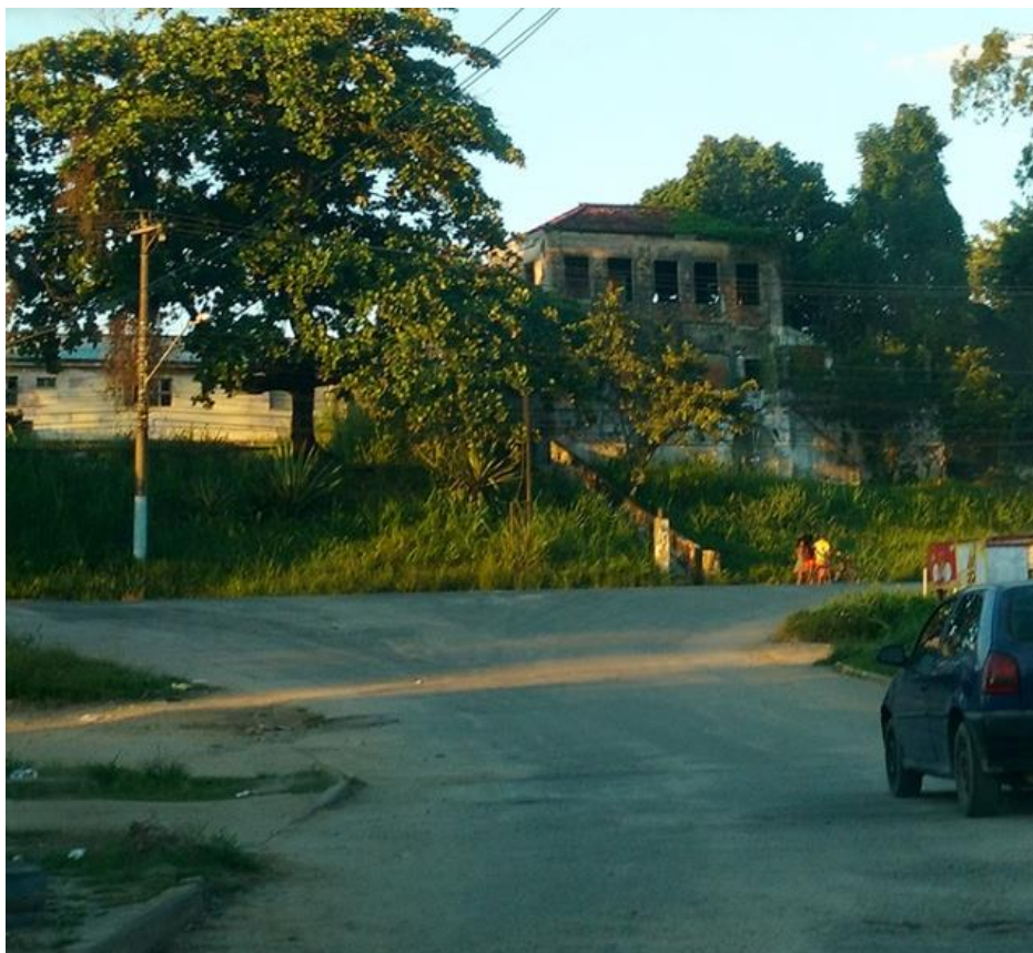
Figura 2 - Sede da Fazenda Magepe-Mirim, a partir da Rua Dona Joaquina. Fonte: Fotografia da autora, 2018.
