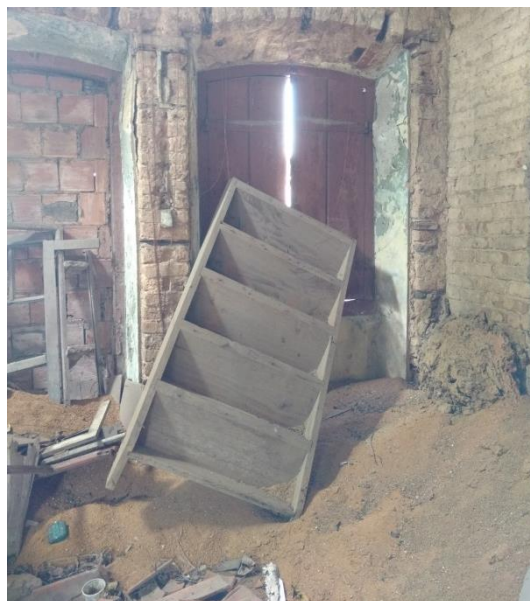
Figura 49 - Parte da escada de madeira desabada no interior do edifício. Fonte: Fotografia da autora, 2016.
