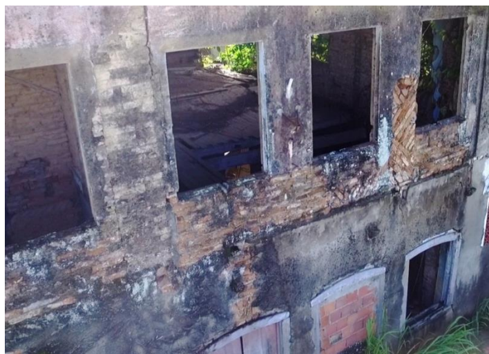
Figura 69 - Tijolos de barro aparentes na fachada. Fonte: Fotografia da autora, 2017.
