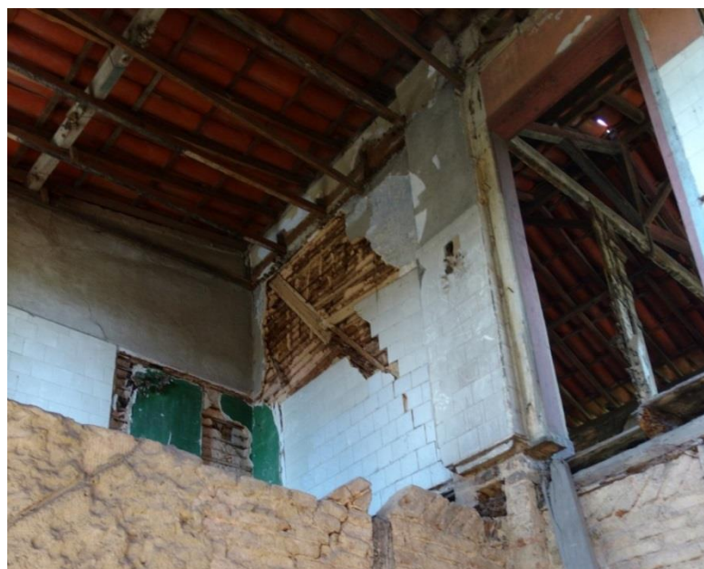
Figura 44 - Paredes do segundo pavimento em pau a pique. Fonte: Fotografia da autora, 2016.
