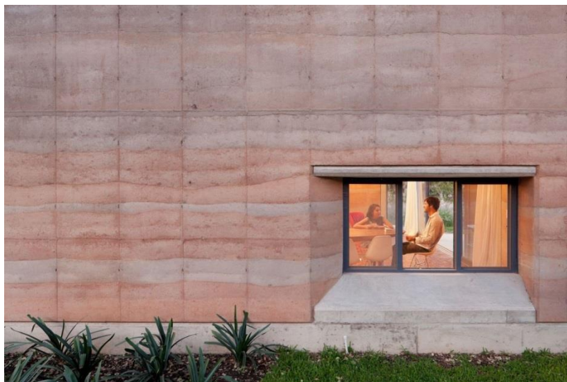
Figura 99 – Casa de Veraneio em Jalostitlán, México, projeto de Tatiana Bilbao S.C. Com utilização de Taipa de Pilão. Fonte: ArchDaily. Disponível em: < https://www.plataformaarquitectura.cl/cl/02-279921/ajjic-tatiana-bilbao-s-c > acesso: Junho de 2018.
