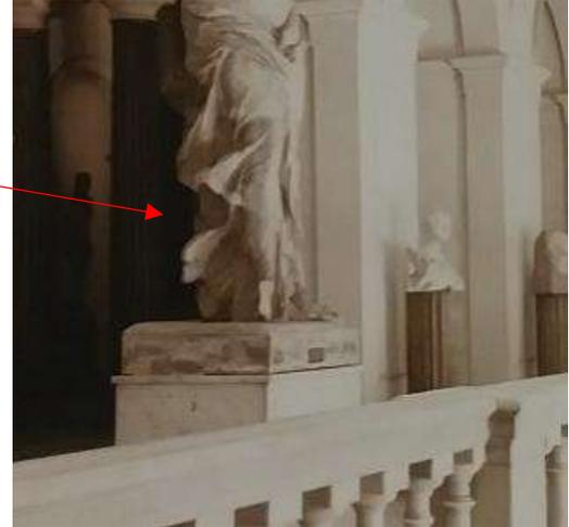
Figura 206 - Detalhe da escultura oxidada e material particulado.
