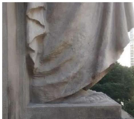
Figura 140 – Escultura *Cariátides* - lado esquerdo da fachada com rachaduras.
