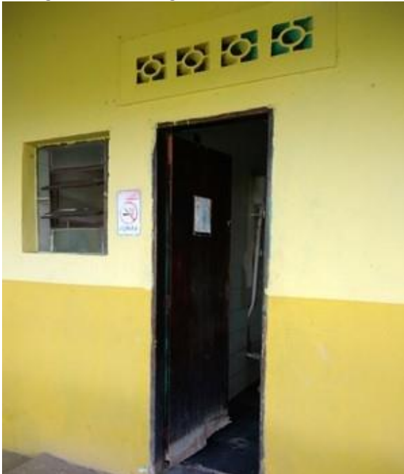
Figura 48 – Cobogó no banheiro masculino
