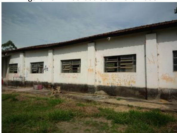
Figura 107 – Fachada do almoxarifado
