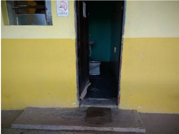
Figura 46 – Entrada do banheiro masculino
