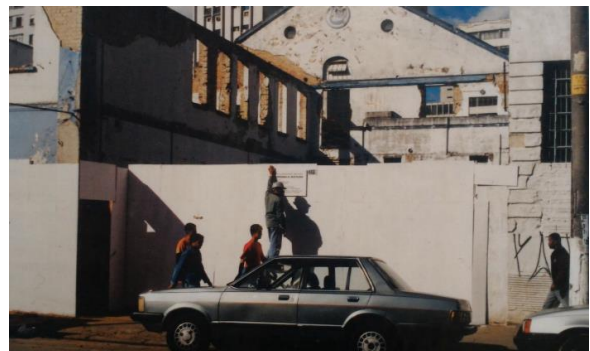
Figura 10 – Início das obras de revitalização
