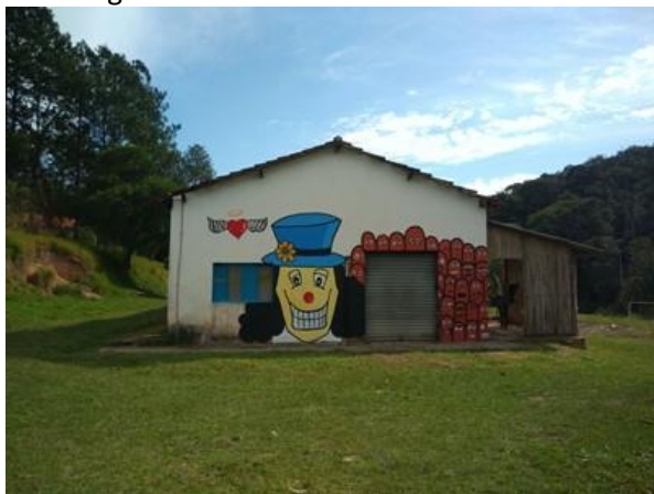
Figura 105 – Fachada do almoxarifado
