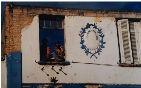
Figura 9 – Brasão original da fachada
