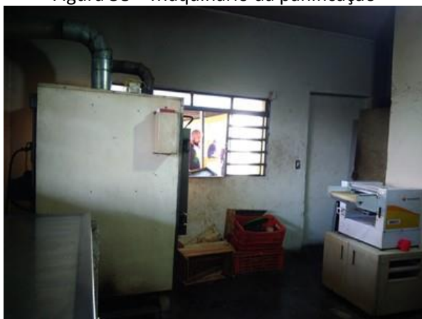
Figura 58 – Maquinário da panificação
