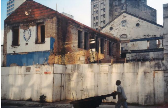
Figura 11 - Fachada antes da revitalização
