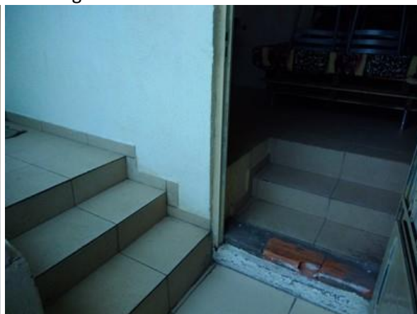
Figura 127 – Escadas de acesso a sala
