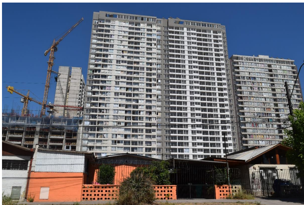
Imagen 65: Contraste entre edificaciones nuevas y originales en Unidad Vecinal N°10. Fuente: Autora, 2018.
