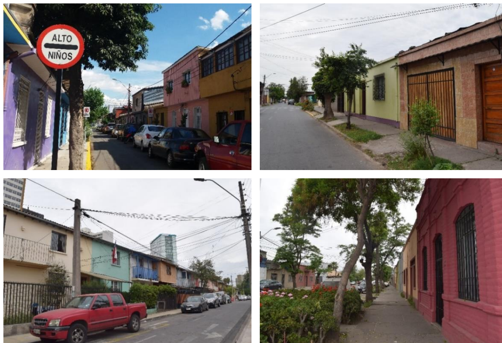
Imagen 29: Viviendas originales de la comuna de Estación Central. Fuente: Autora, 2018
