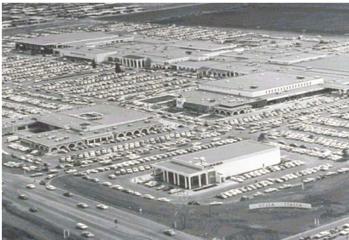
Figura 2.16. Foto aérea do Shopping Belmar antes do processo de revitalização urbana. Fonte: Urban Land Institute
