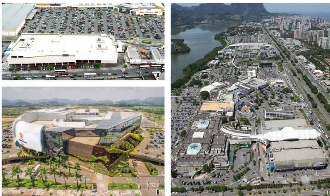
Figura 3.21. Exemplos de Shoppings Rodoviários. Protagonismo dos espaços para estacionamento de veículos e edifício isolado no lote. A: Shopping Grande Rio; B: Shopping Metropolitano da Barra e C: Barra Shopping e New York City Center. Fontes: A: Alianse; B: Paulo Baruki; C: Multiplan
