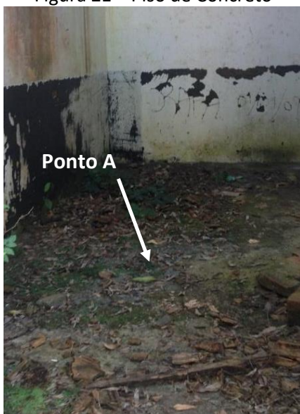
Figura 21 – Piso de Concreto
