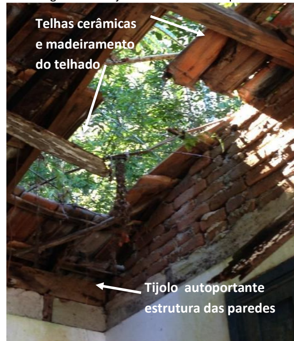
Figura 115 - Tijolos da estrutura da parede
