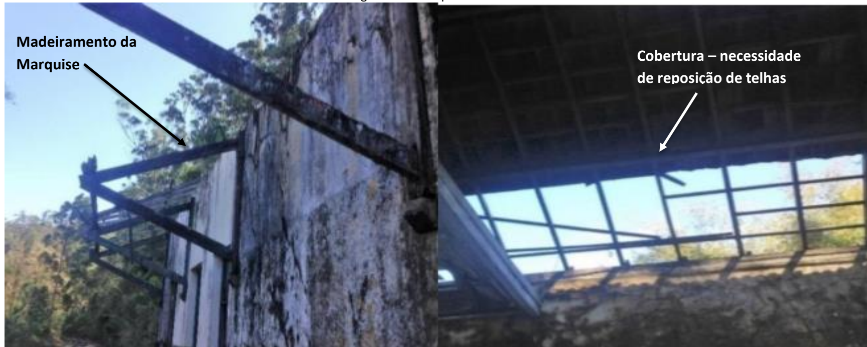
Figura 17 – Marquise e Telhado
