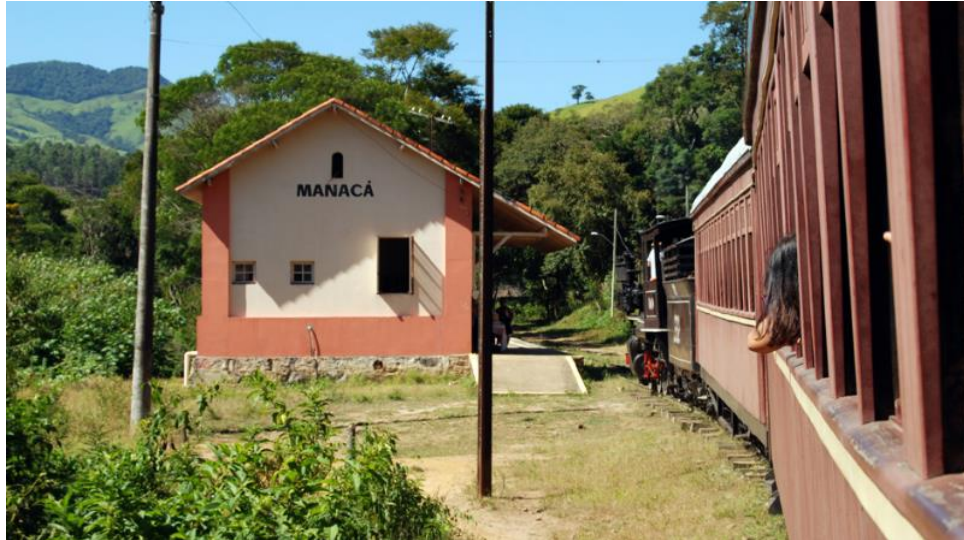
Figura 40 – Estação de Manacá
