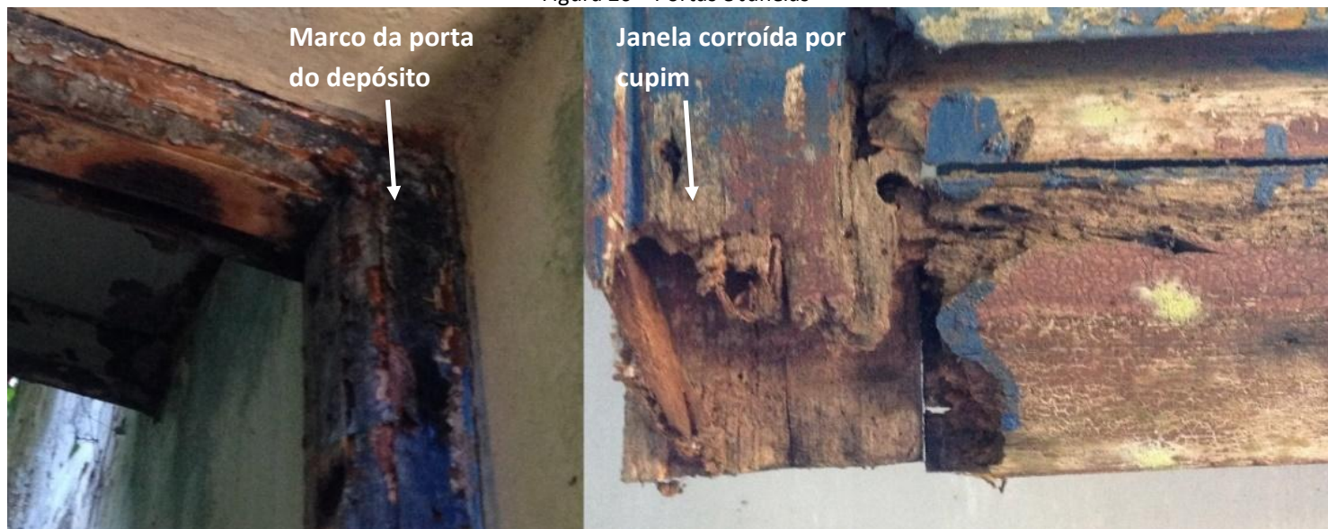
Figura 26 – Portas e Janelas
