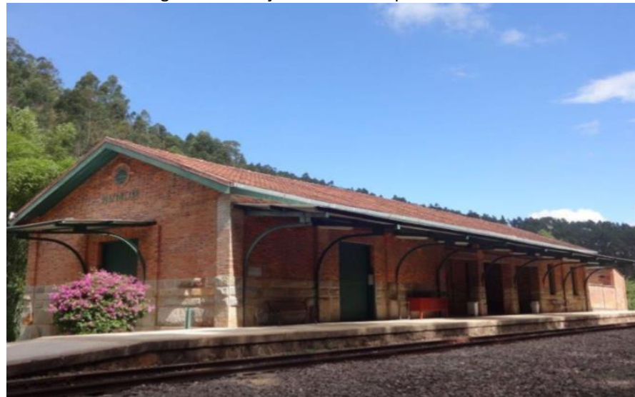
Figura 33 - Estação de Matilde após o restauro
