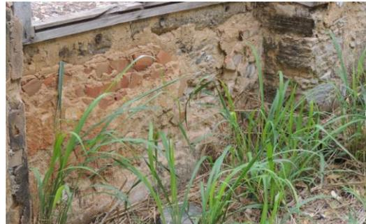
Figura 115 – Em detalhe um trecho de remendo com argamassa diferenciada. Registrado pela autora. Janeiro/ 2018
