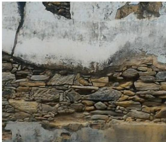
Figura 87 -- Detalhe da alvenaria em pedra exposta. Registrado pela autora. Janeiro/ 2018
