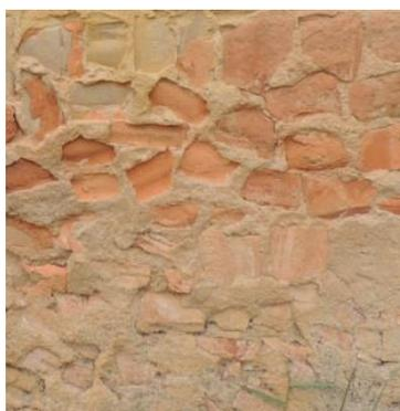
Figura 92 - Detalhe de reparos realizados com argamassa diferenciada. Registrado pela autora. Janeiro/ 2018
