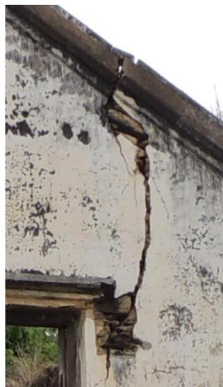
Figura 89 - Detalhe da rachadura na alvenaria em pedra. Registrado pela autora. Janeiro/ 2018
