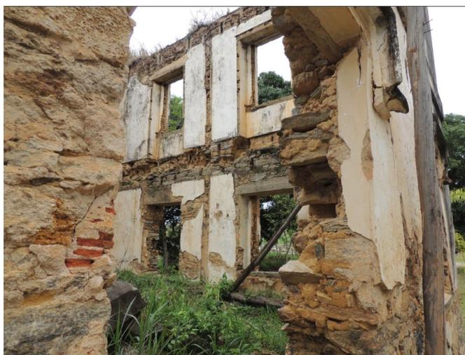
Figura 106 – Fachada interna com marcações da estrutura da laje, vigas e paredes internas. Registrado pela autora. Janeiro/ 2018
