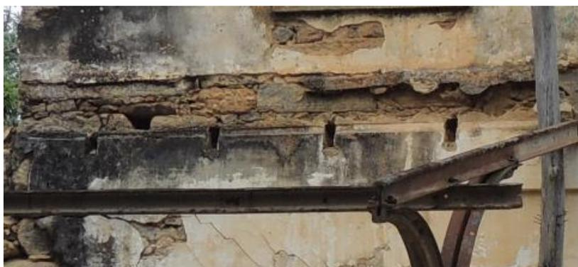
Figura 99 - Detalhe dos encaixes expostos. Registrado pela autora. Janeiro/ 2018
