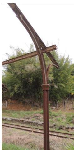
Figura 101 - Detalhe da estrutura em ferro fundido apresentando corrosão. Registrado pela autora. Janeiro/ 2018
