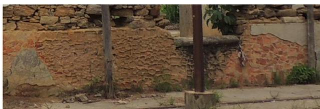
Figura 96 - Detalhe do roda-meio existente na fachada da plataforma. Este elemento é composto por argamassa pintada em tinta cinza e detalhe em madeira que faz a divisão entre a parte branca e a cinza. Registrado pela autora. Janeiro/ 2018
