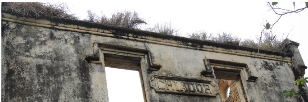
Figura 97 - Detalhe para vegetação nascendo na parede em que era apoiado a estrutura da antiga cobertura. Registrado pela autora. Janeiro/ 2018
