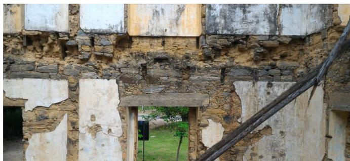
Figura 107 - Detalhe para o encaixe da laje e vigas que ruíram e do engaste da antiga parede interna. Registrado pela autora. Janeiro/ 2018
