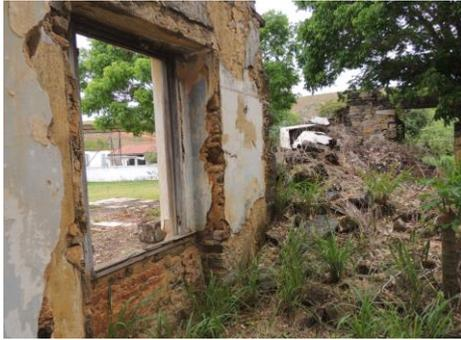
Figura 112 – Parte interna deteriorada do torreão 2. Registrado pela autora. Janeiro/ 2018
