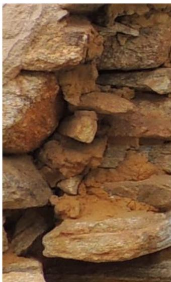
Figura 88 - Detalhe da estrutura em alvenaria de pedras e barro que foi utilizada para construção de todas as paredes da estação. Registrado pela autora. Janeiro/ 2018
